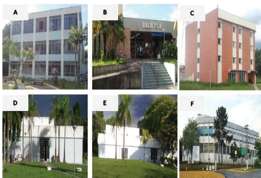
Figura 15 – Fachadas dos prédios: A – Blocos I, II, III e IV. B – Biblioteca. C – Moradia. D – Civil Cotec. E – Mecânica Cotec. F – Ginásio
