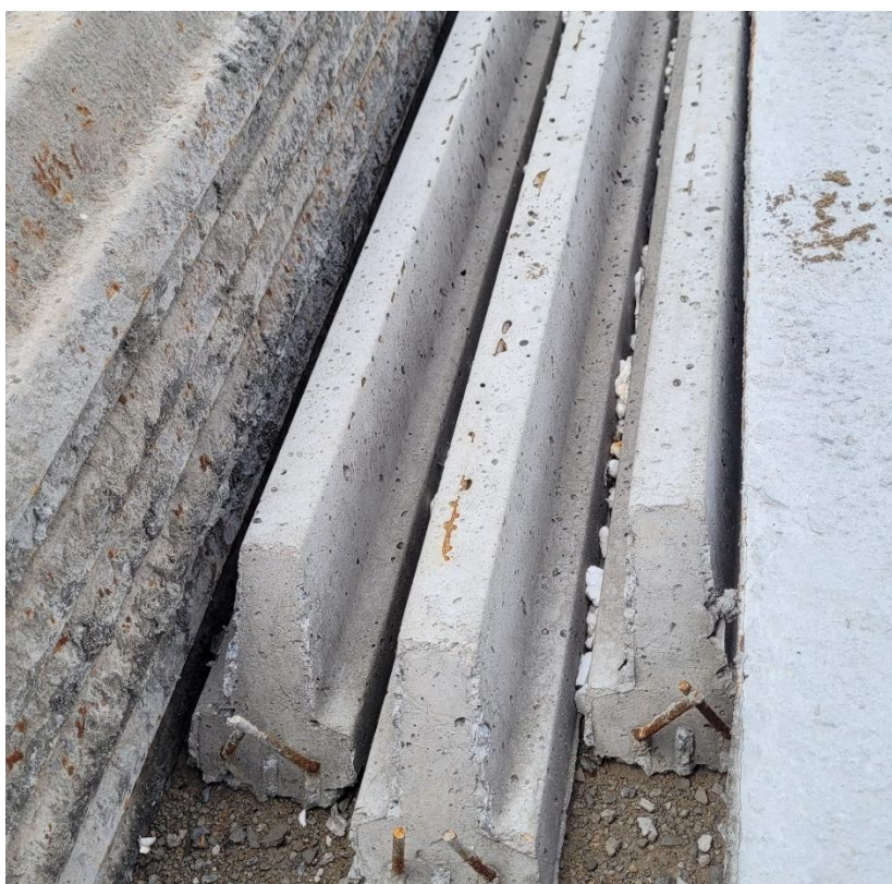
Foto 16 – Vigota com armadura exposta – Empresa B
