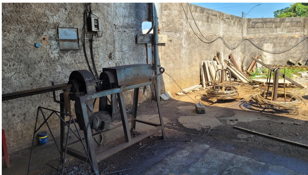
Foto 6 – Corte das armaduras adicionais – Empresa A
