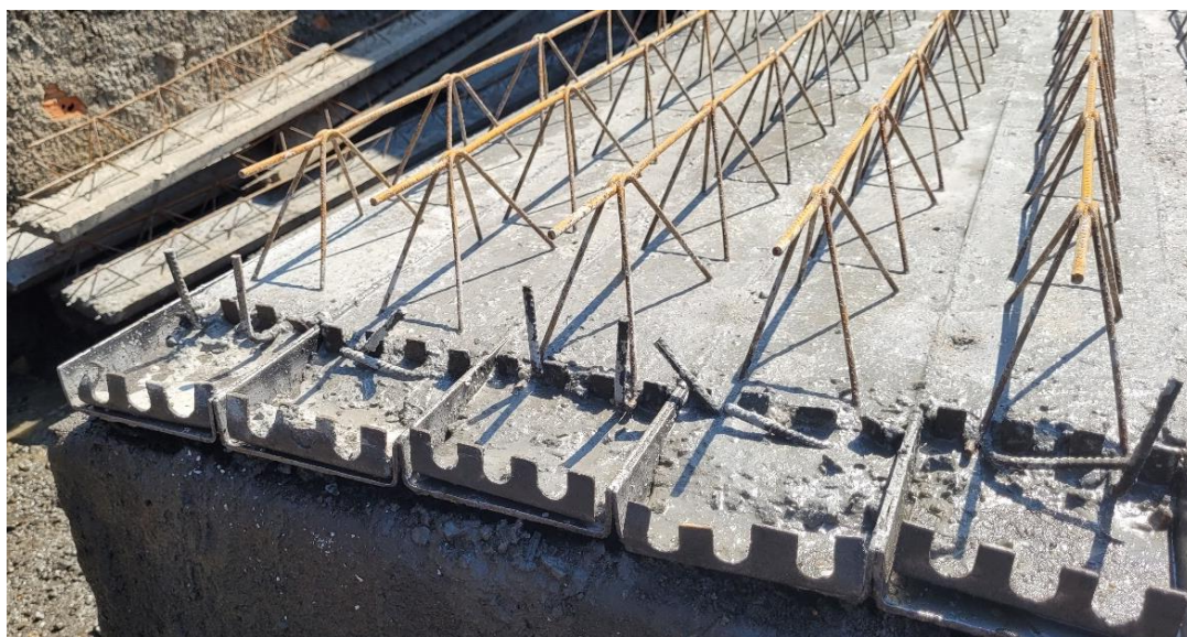
Foto 7 – Fôrmas de vigotas treliçadas – Empresa A
