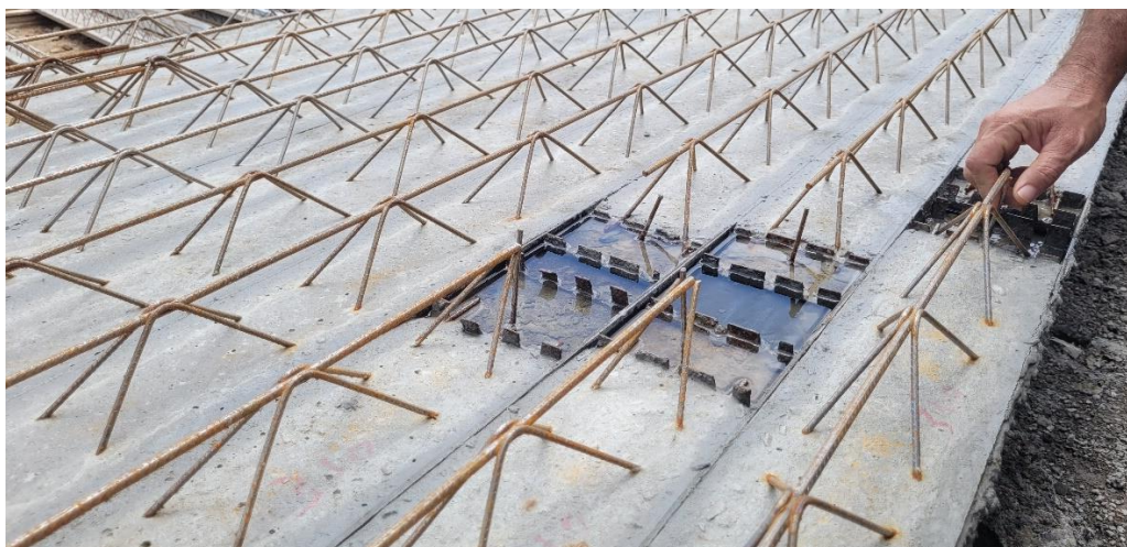
Foto 13 – Cura das vigotas treliçadas nas fôrmas – Empresa B
