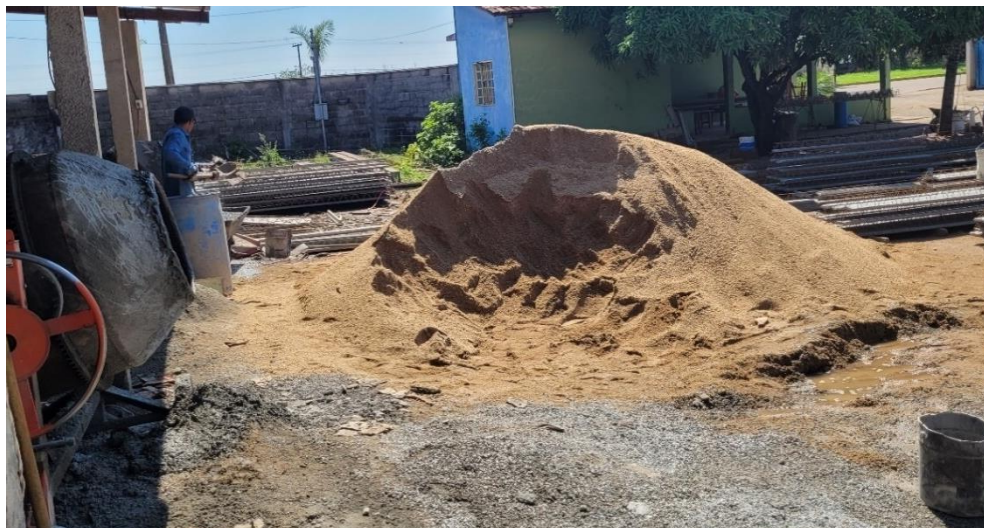
Foto 2 – Armazenamento da areia grossa – Empresa A
