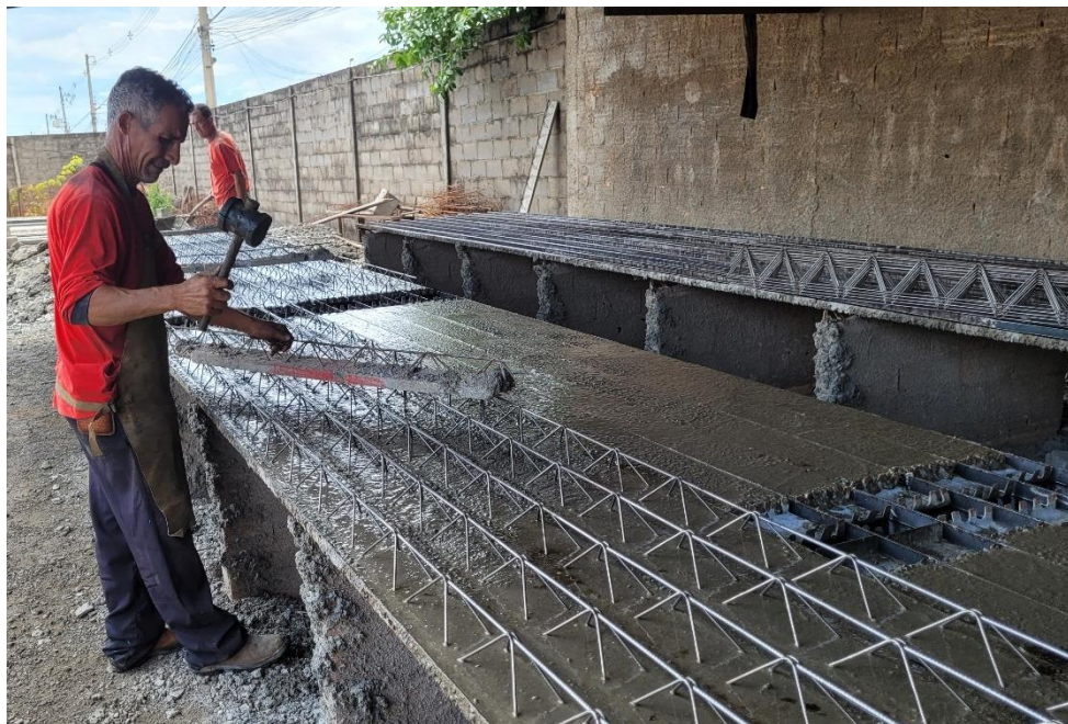
Foto 14 – Adensamento do concreto nas fôrmas – Empresa B
