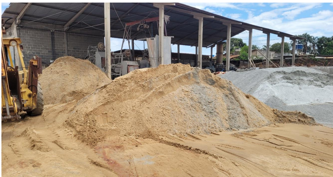
Foto 11 – Armazenamento dos agregados Empresa B
