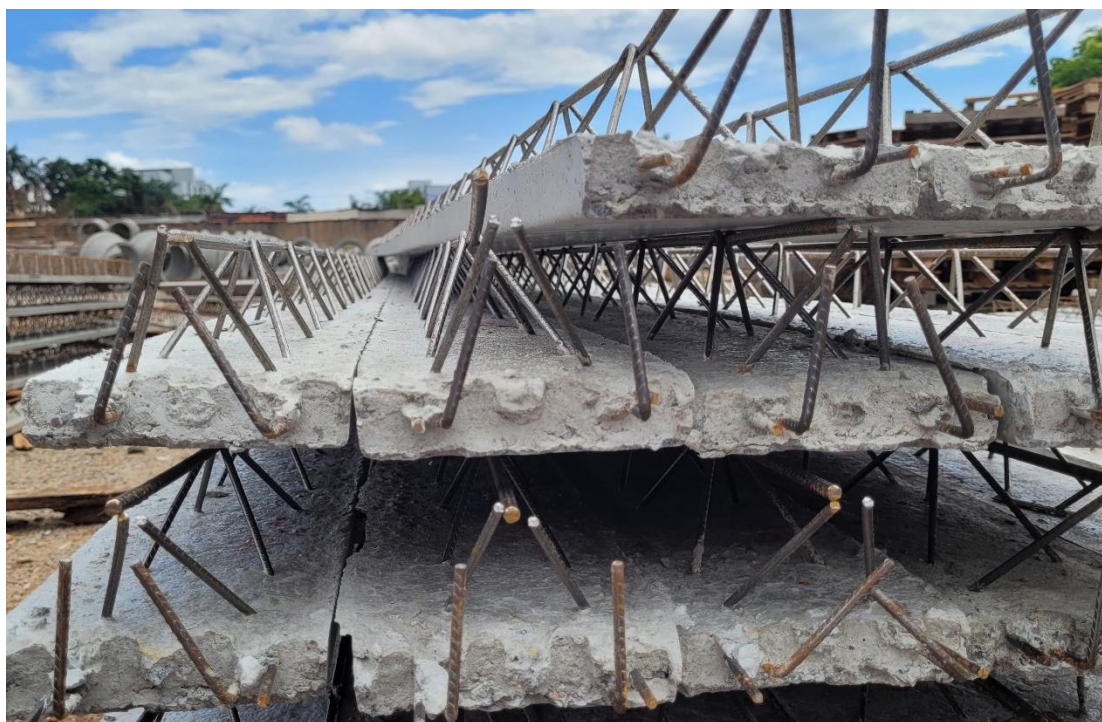
Foto 15 – Seção transversal da vigota treliçada
