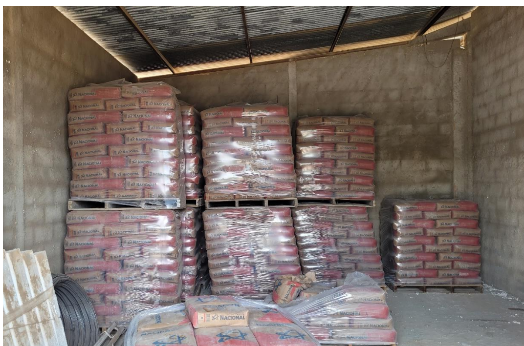
Foto 10 – Armazenamento do cimento – Empresa B
