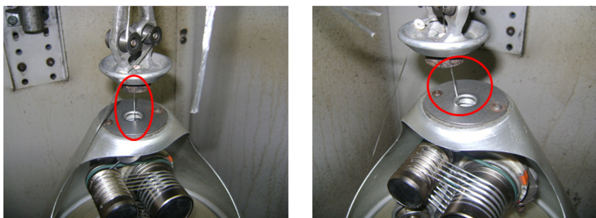
Figura 20 - Exemplo de passamento correto à esquerda e de passamento incorreto à direita (gerador de bobinas de quebra) do fio singelo no Pote durante o processo de transformação em cableadoras.
