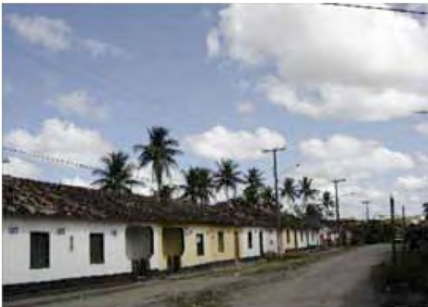
Imagem 27 – Foto do bloco de casas contíguas da Usina Cuacú. ( Fonte: CAMPAGNOL, 2008)
