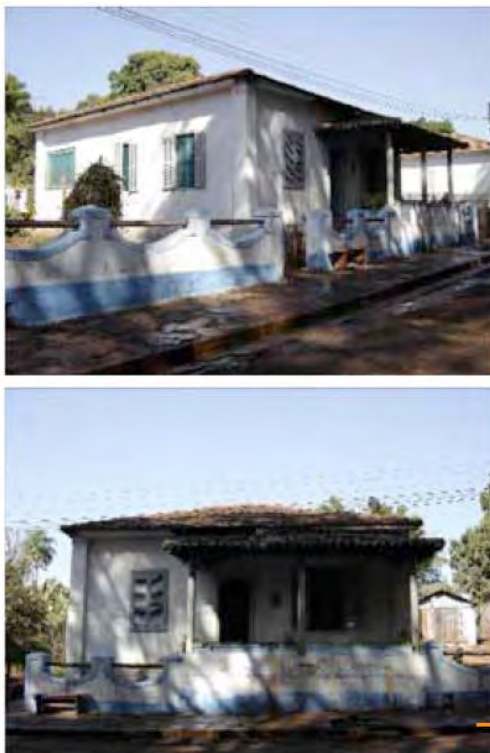
Imagem 22 - Foto de casa isolada da usina Tamoio em Araraquara. (CAMPAGNOL, 2008)
