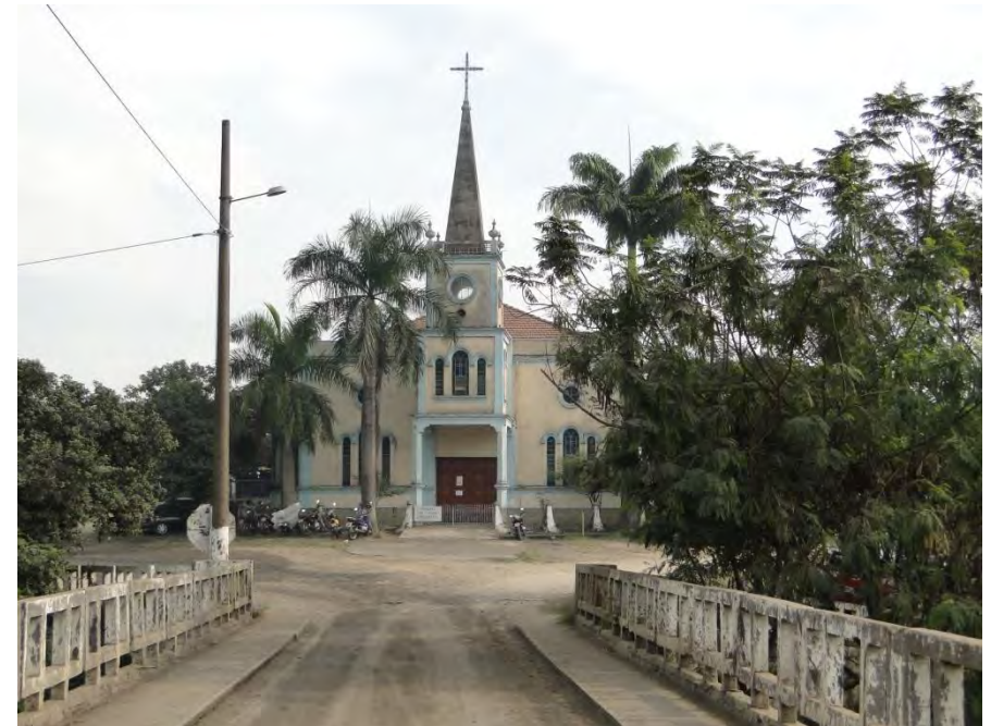
Imagem 53 – Foto igreja. (Fonte: L. MACHADO, 2011)
