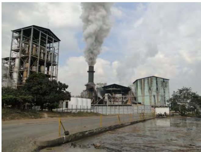
Imagem 41 – Foto area fabril usina Furlan. (Fonte: L.MACHADO, 2011)
