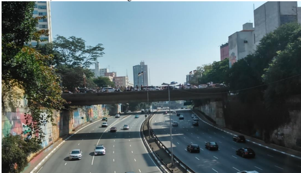
Figura 29. Vista do viaduto Mie-Kem para o viaduto Osaka; o Jardim Oriental localiza-se atrás deste, no lado direito da imagem. Abaixo a Radial Leste-Oeste.
