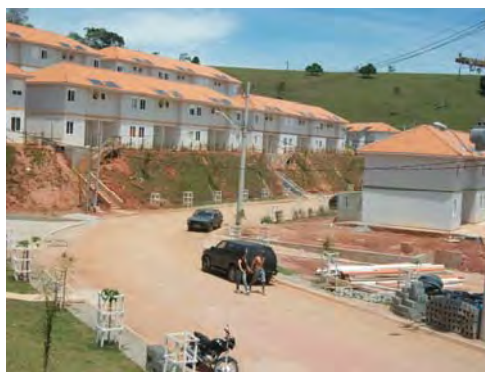
Figura 65: Cortes no terreno das casas da CDHU. Fonte: Autor.
