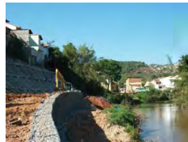
Figura 37: Proteção das margens com gabião. Fonte: Autor.
