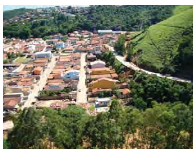
Figura 60: Detalhe área com risco alto. Fonte: IPT, 2010
