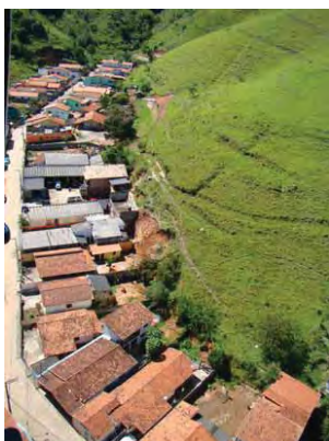
Figura 59: Detalhe área com risco médio. Fonte: IPT, 2010.
