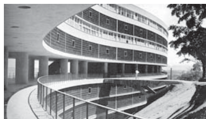
Figura 11: Conjunto habitacional Pedregulho, Rio de Janeiro.
