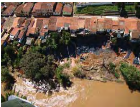
Figura 61: Detalhe área com risco muito alto. Fonte: IPT, 2010.
