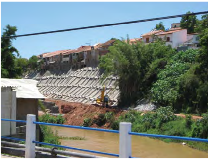
Figura 38: Concretagem do talude. Fonte: Autor.
