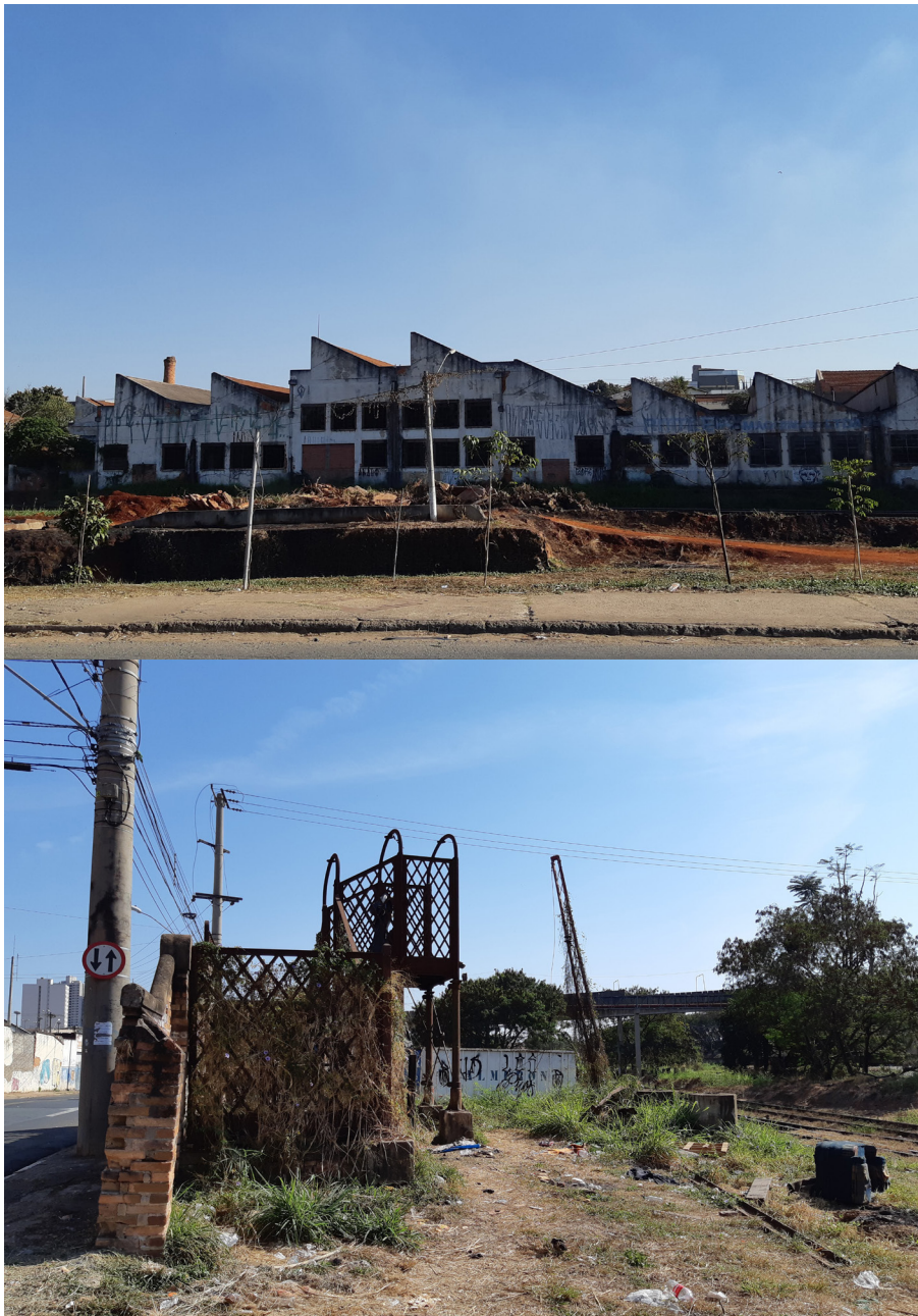
Construções no “Centro Abaixo”. Fonte:arquivo próprio, 2018.
