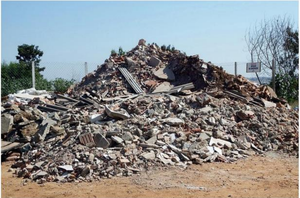
Figura 02 - Entulho de resíduo de construção civil armazenado em um dos Ecopontos de Piracicaba
