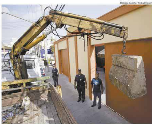
Funcionários da prefeitura fecham com blocos de concreto a casa de swing Shadows, em SP
