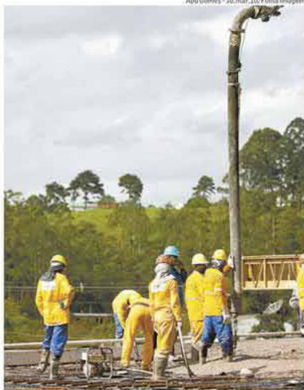
Operários na obra do trecho sul do Rodoanel em março deste ano
