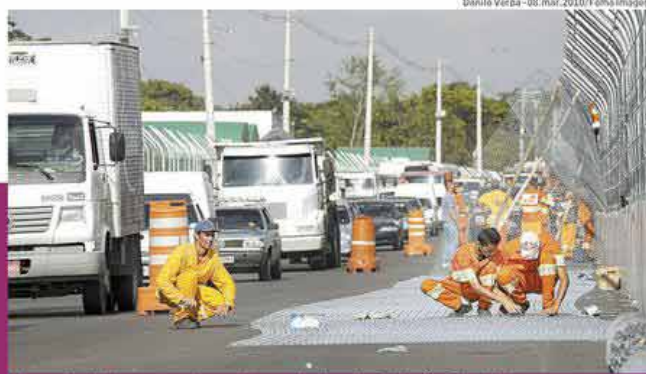
Homens trabalham na montagem das grades de proteção do circuito da Indy, na zona norte
