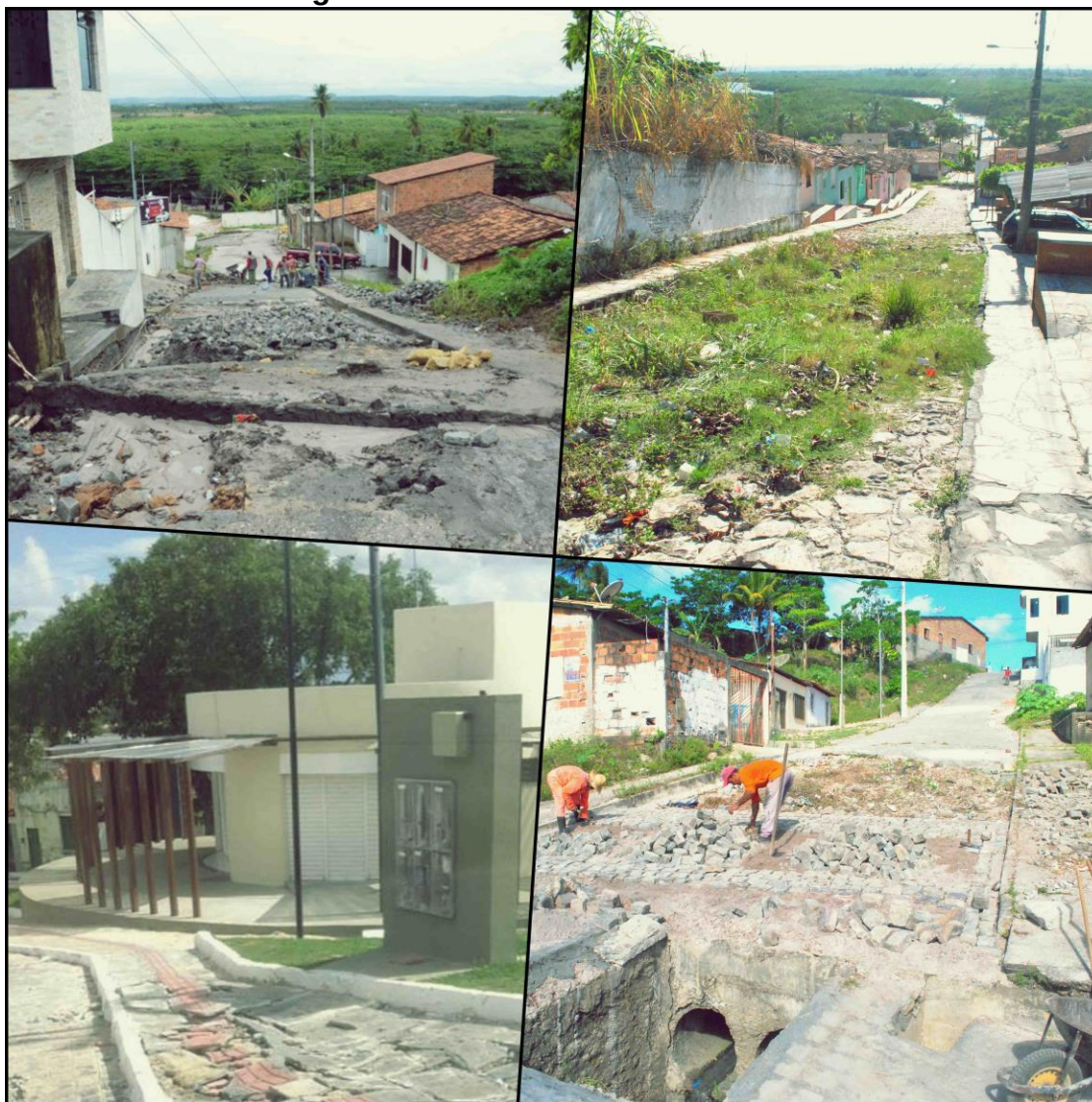
Figura 31 – Erosão em São Cristóvão.
