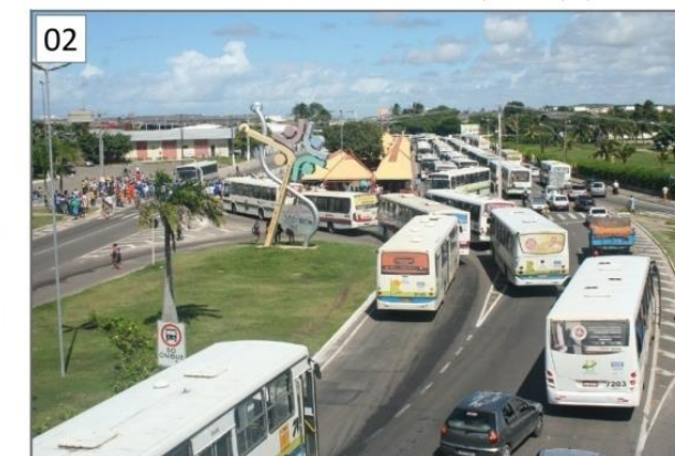
Terminal D.I.A. (Av. Pref. Heráclito Rollemberg)
