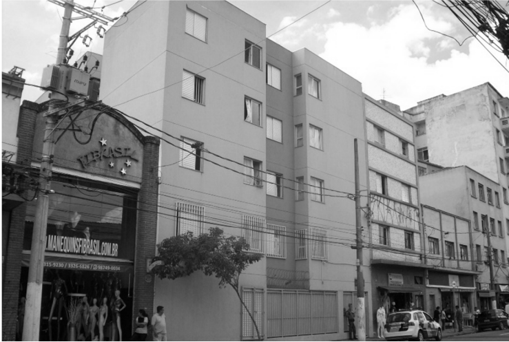
Figura 20: Residencial São Caetano, Rua São Caetano
