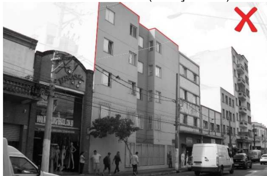
Figura 58: Residencial São Caetano: fachada não escalonada (situação real)
