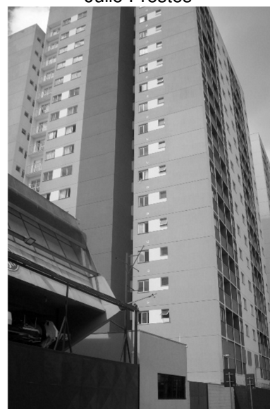
Figura 19: Torre do Complexo Júlio Prestes
