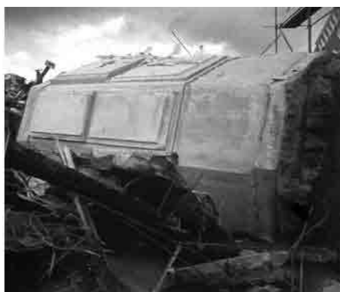
FOTO 25 e 25 A - Demolição da Casa
