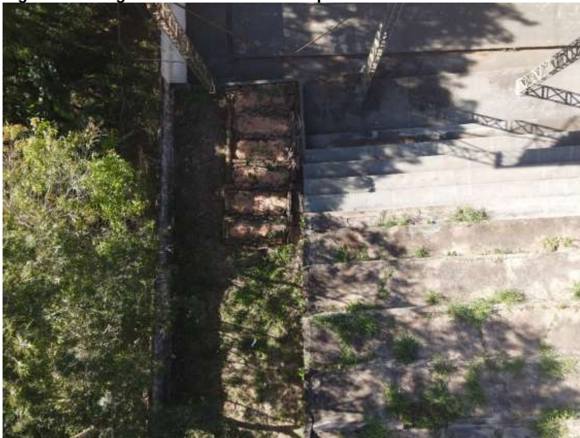
Figura 58 – Registro dos canteiros feito por drone
