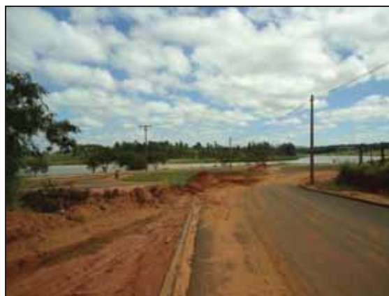
Foto 18 - Balneário da amizade: obras de infraestrutura proposto pelo projeto de Presidente Prudente. Fonte: SOARES, 2011.
