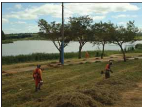
Foto 17 - Balneário da amizade: obras do projeto de Presidente Prudente. Fonte: SOARES, 2011.
