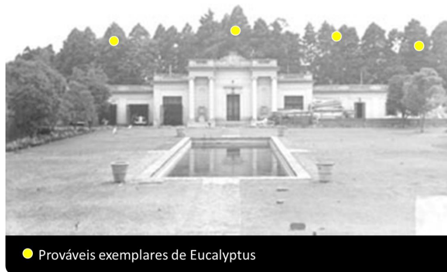
Figura 210 - Vista da residência de Francisco Matarazzo na Avenida Paulista [19-].
