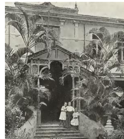
Figura 39 – Entrada do edifício sede do IAE.
