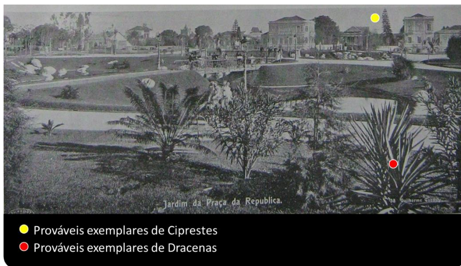
Figura 197 - Vista nº 1 do Jardim da Praça da República em São Paulo [1910].
