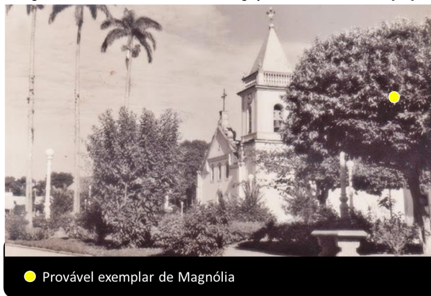
Figura 128 – Vista do Jardim do entorno da Igreja Matriz de São Sebastião [19-].
