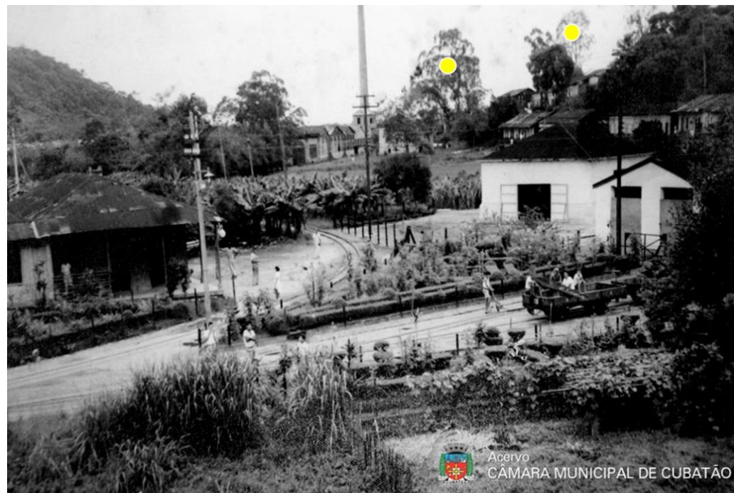
Figura 131 - Vista do Armazém do Sr. Alberto Costa no Bairro Cortume em Cubatão [1949].
