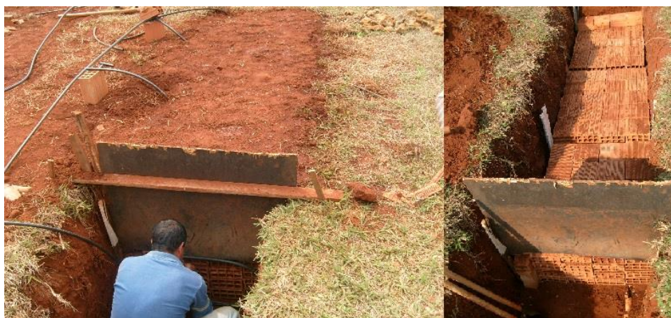
Figura 3. Instalação do sistema com 4,0 m com aspersores intercalados a cada metro linear.
