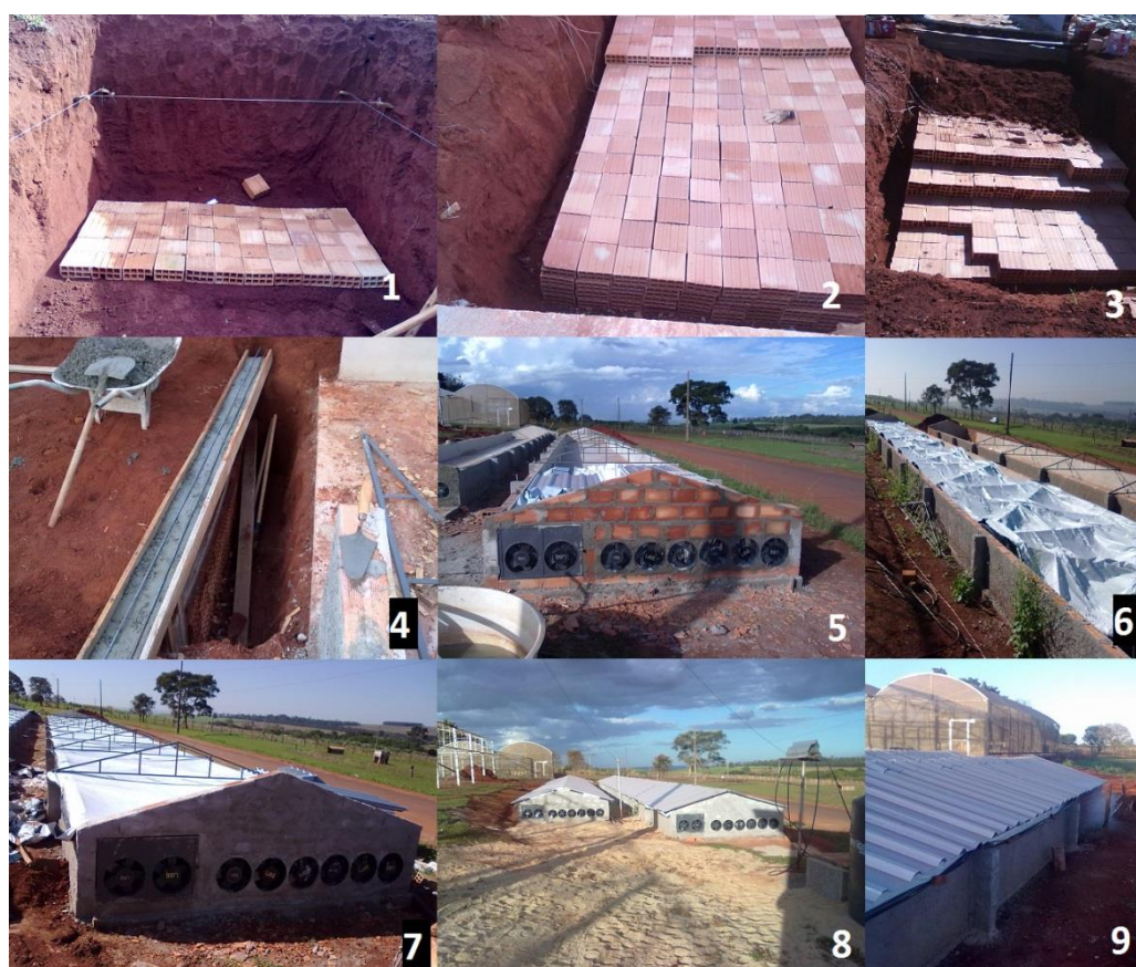
Figura 3 - Detalhe da construção do sistema de entrada de ar via solo, forração e telhamento.
