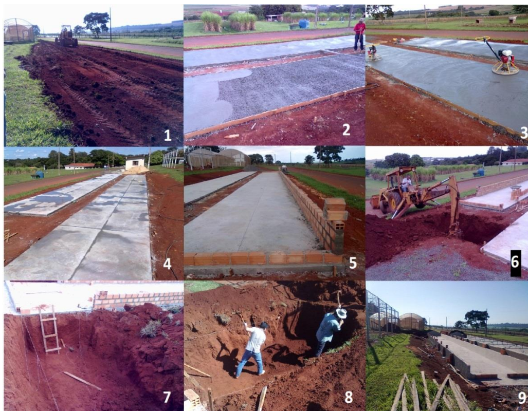
Figura 2 - Infraestrutura e superestrutura dos dois galpões.
