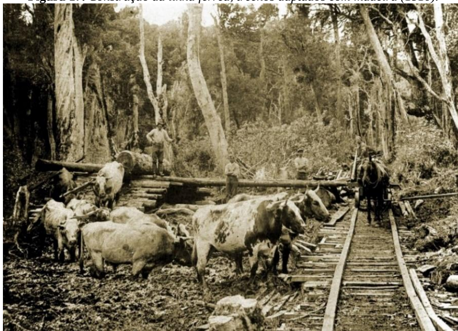
Figura 17. Construção da linha férrea, trechos adptados com madeira (1910).
