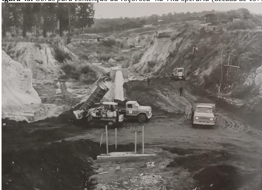
Figura 45. Obras para contenção da voçoroca 9 na Vila operária (década de 1970).
