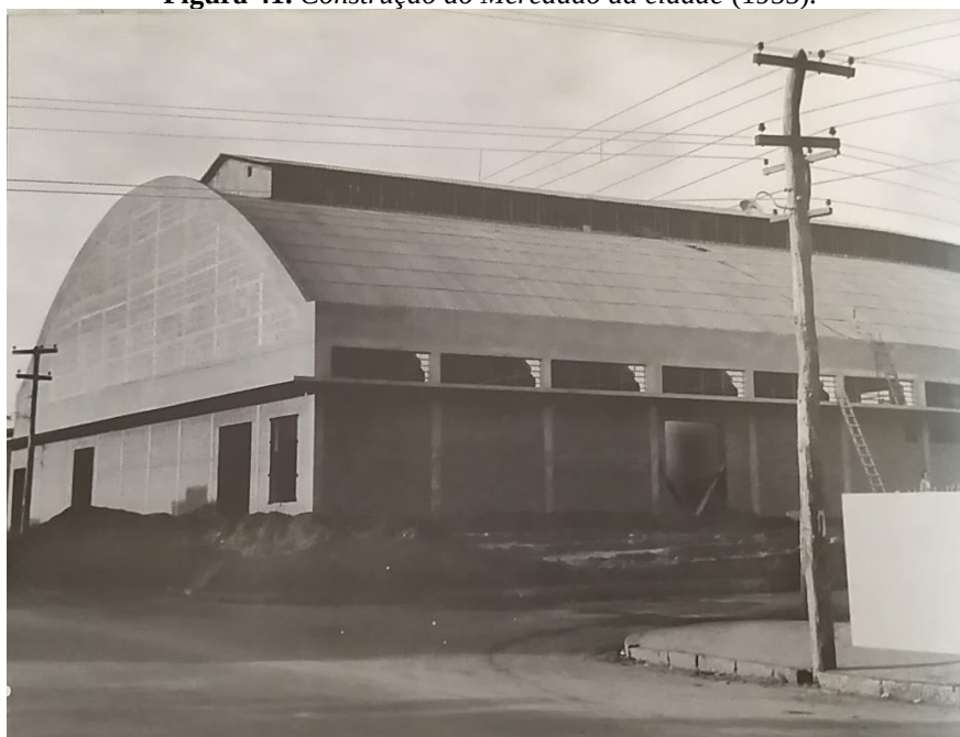
Figura 41. Construção do Mercadão da cidade (1955).
