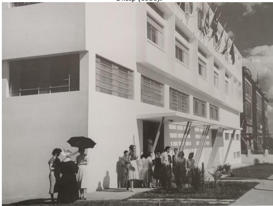
Figura 42. Prédio provisório do Instituto Isolado de Ensino Superior, que posteriormente veio a ser chamado de Unesp (1956).
