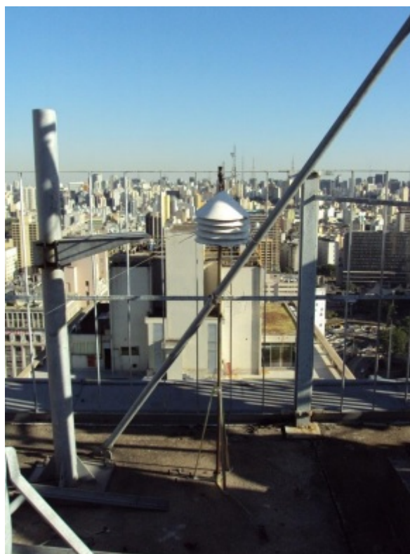
Figura 33 – Sensor 3 colocado na cobertura do edifício Mercantil
