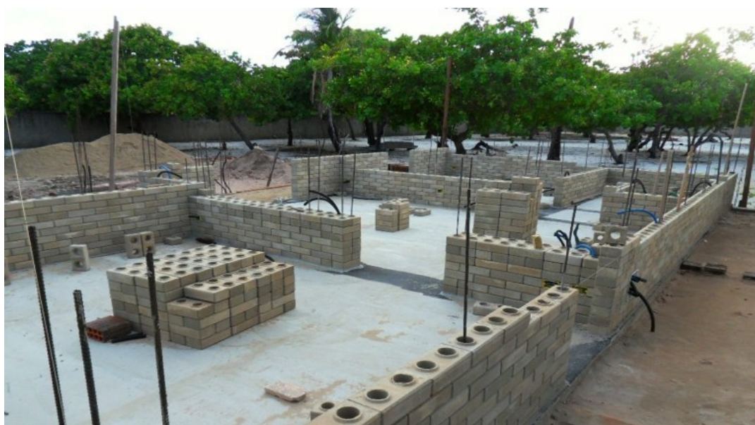
Figura 1 – Exemplo de obra com tijolo ecológico
