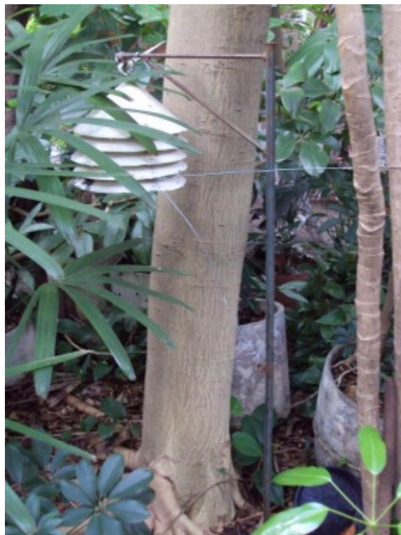
Figura 32 – Sensor 2 colocado na cobertura do edifício Matarazzo
