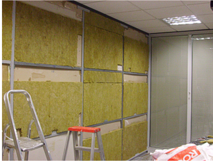
Figura 4 – Instalação de placas de lã de rocha em uma parede de escritório
