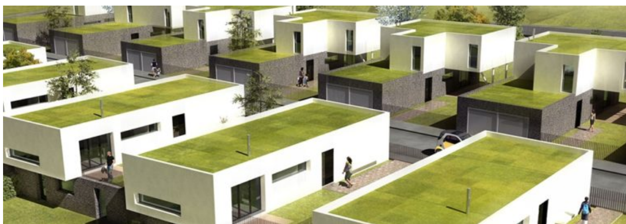
Figura 27 – Exemplo de construção com telhado verde extensivo
