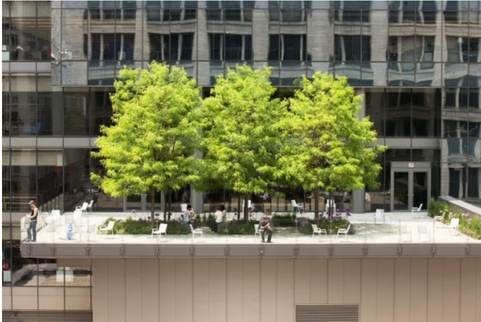
Figura 28 – Exemplo de telhado verde intensivo - Edifício Morningstar Corporation - Empresa de investimentos localizada em Chigaco, EUA
