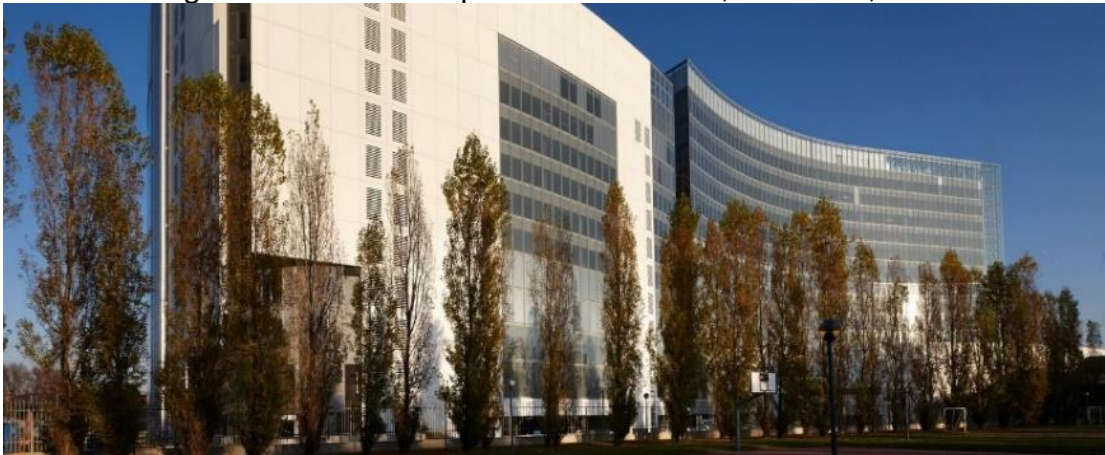
Figura 7 - Edifício corporativo Vodafone, em Milão, Itália
