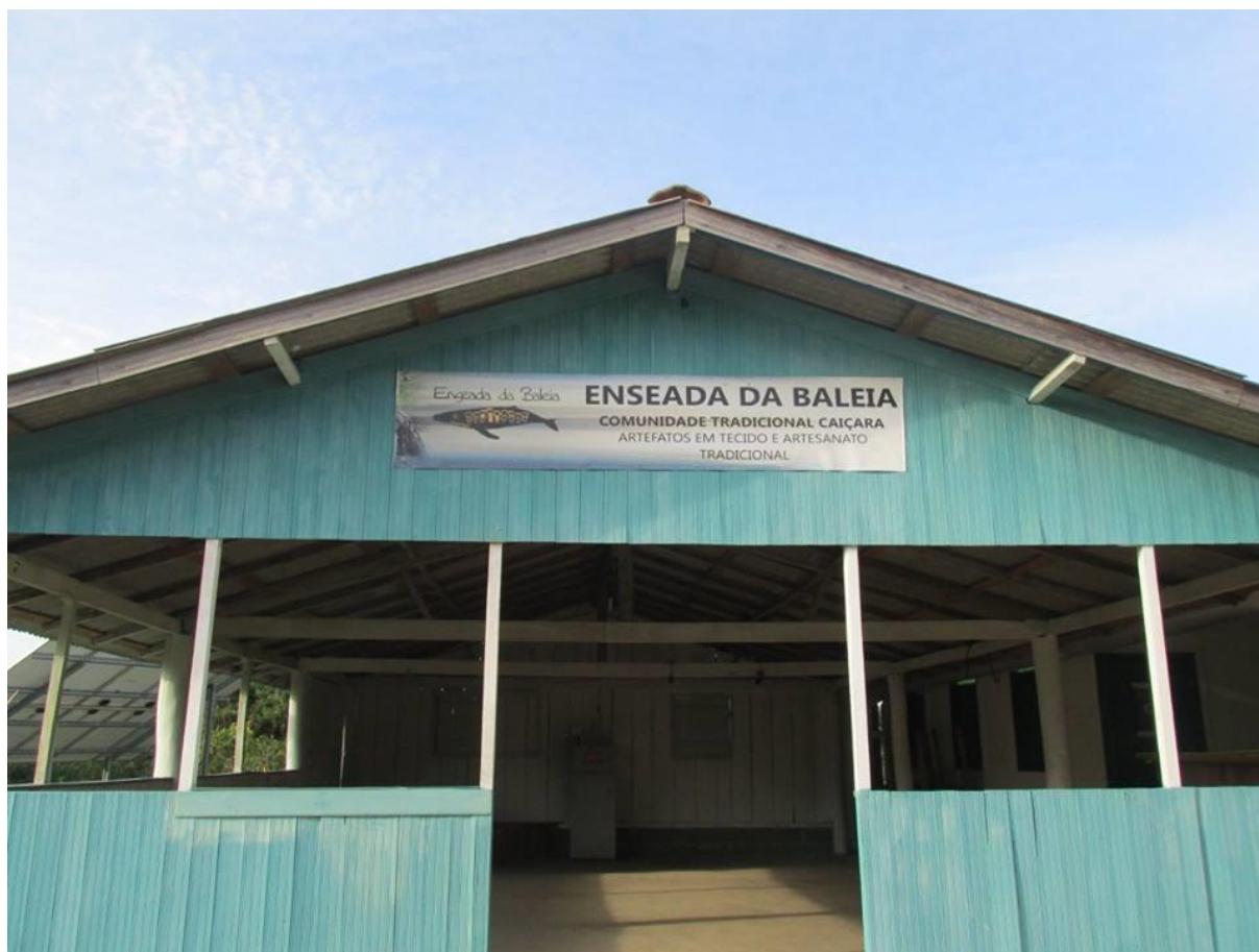
Figura 31: Centro Comunitário da Enseada da Baleia. Local onde as mulheres trabalham coletivamente. Fonte: Arquivo de Pesquisa, 2016. Foto: Alexandra Filipak.
