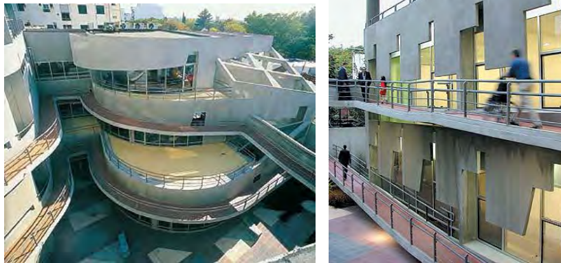
Figura 19. Vistas das rampas do Centro de Reabilitação Motora em Vicente López.
