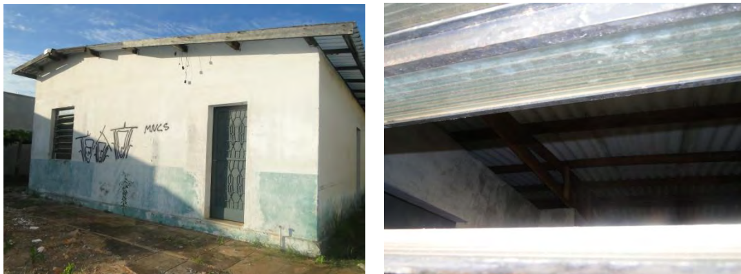
Figura 8. Imagens da edificação existente e suas tesouras aparentes.
