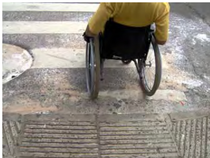
Figura 18 – Rampa regular no cruzamento das Ruas Primeiro de Agosto X Agenor Meira
