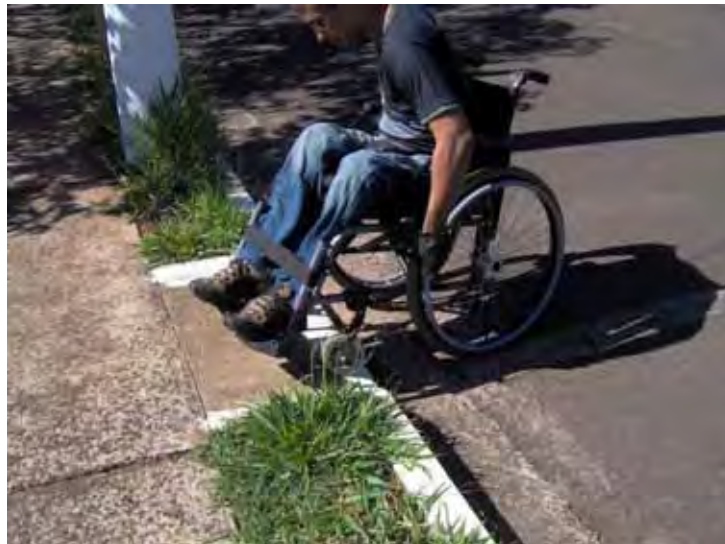
Figura 34 – Rebaixamento de calçada para acesso ao anfiteatro “Guilhermão”
