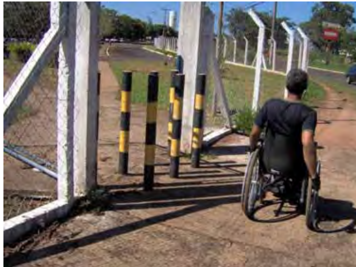
Figura 37 - Detalhe dos tubos situados nas passagens
