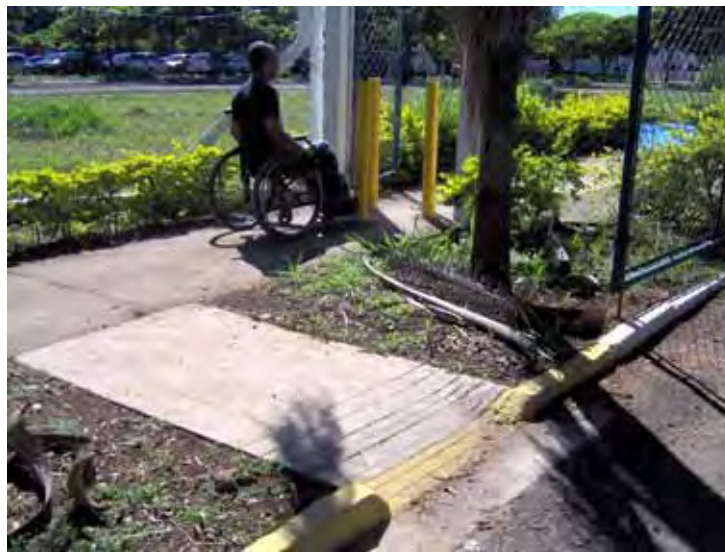
Figura 42 – Rebaixamento de calçada e portão para pedestres com impedimento
