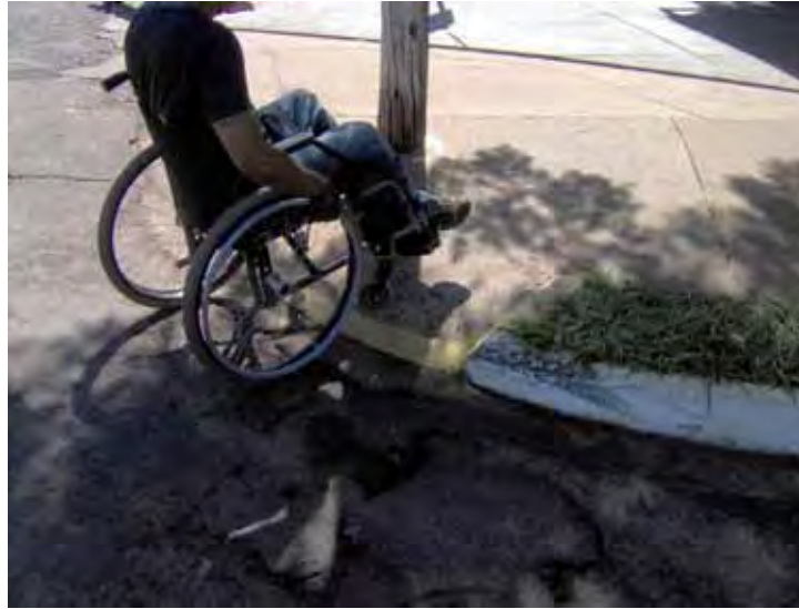
Figura 30 – Rebaixamento de calçada irregular para acesso à copiadora
