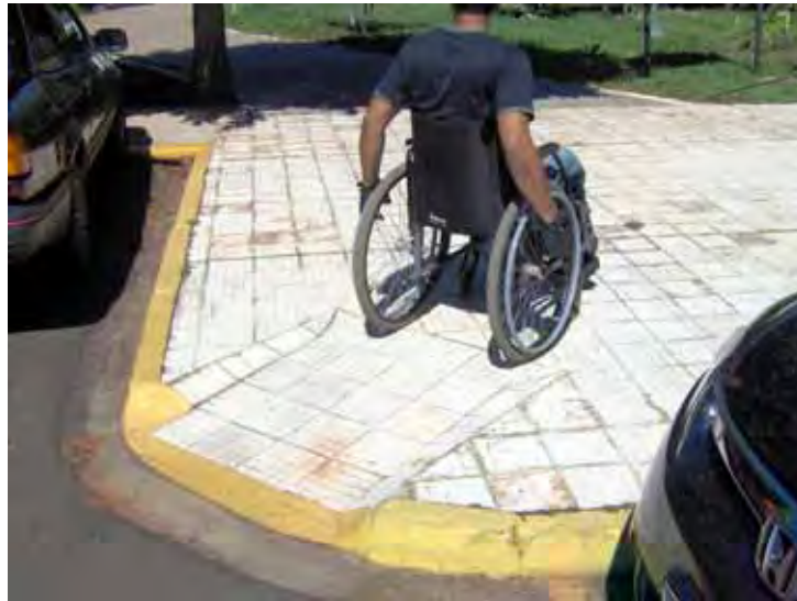
Figura 43 – Rebaixamento de calçada regular próximo ao prédio da Administração da Faculdade de Engenharia
