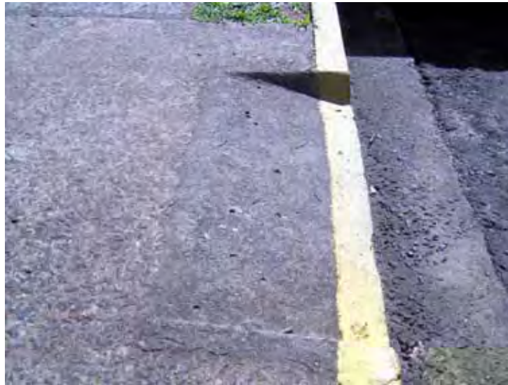
Figura 32 - Rebaixamento de calçada que dá acesso aos Departamentos da FAAC
