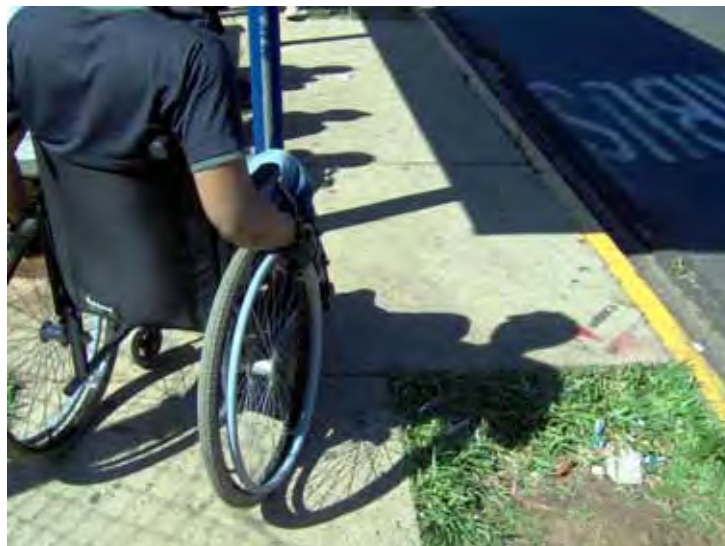
Figura 39 - Piso irregular próximo ao ponto de ônibus
