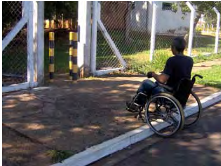
Figura 38 - Ausência de rebaixamento de calçada próximo às passagens
