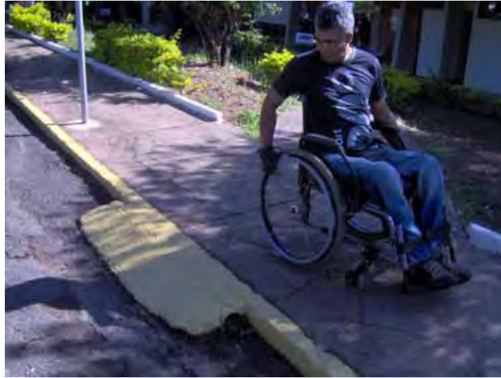
Figura 24 - Detalhe da adaptação feita para o acesso à calçada
