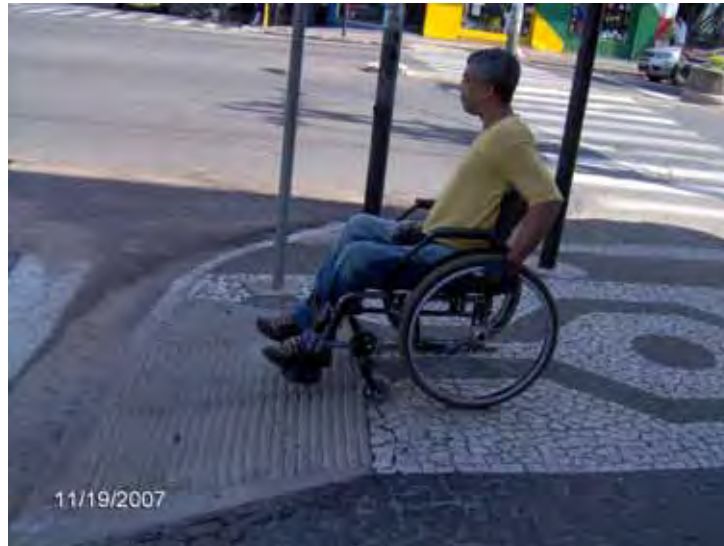
Figura 17 – Rampa regular no cruzamento da Avenida Rodrigues Alves X Rua Virgílio Malta
