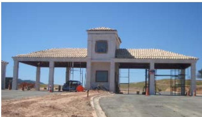
Figura 18: Construção da portaria do condomínio Campos de Santo Antonio II. Fonte: SAVIOLI, G. F., 2012.
