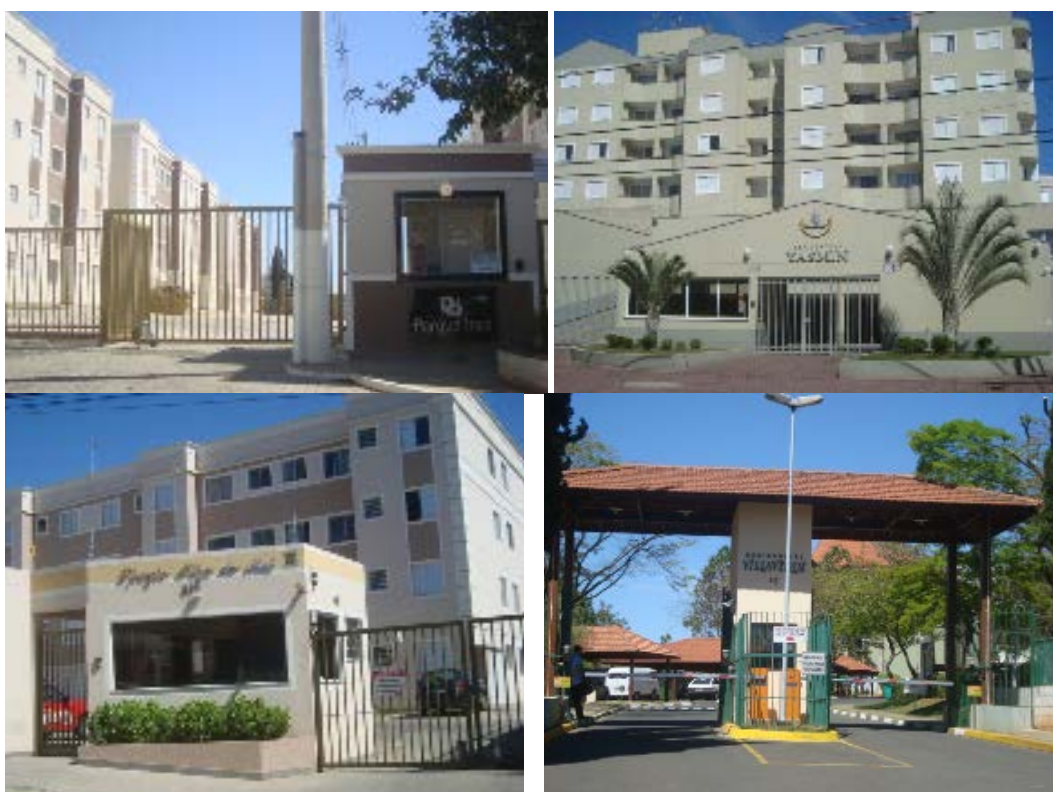
Figura 40: Portaria de condomínios verticais em Itu: Spazio Parque Inca, Residencial Yasmin, Spazio Ilha do Mel e Residencial Villaverde, respectivamente. Fonte: SAVIOLI, G. F., 2012.
