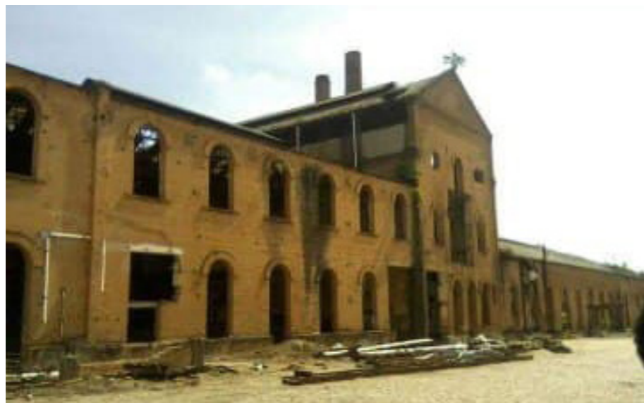
37 Usina de Açúcar desativada, 2014.
