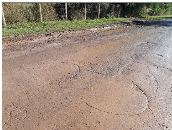
Figura 18 – Umidificação na estrada do Barro Preto em Cordeirópolis/SP. Fonte: Elaborado pelo autor (2018)
