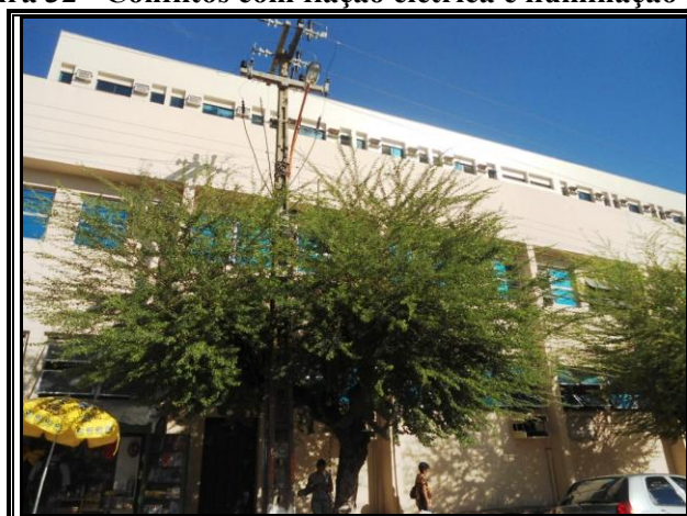
Figura 32 - Conflitos com fiação elétrica e iluminação pública
