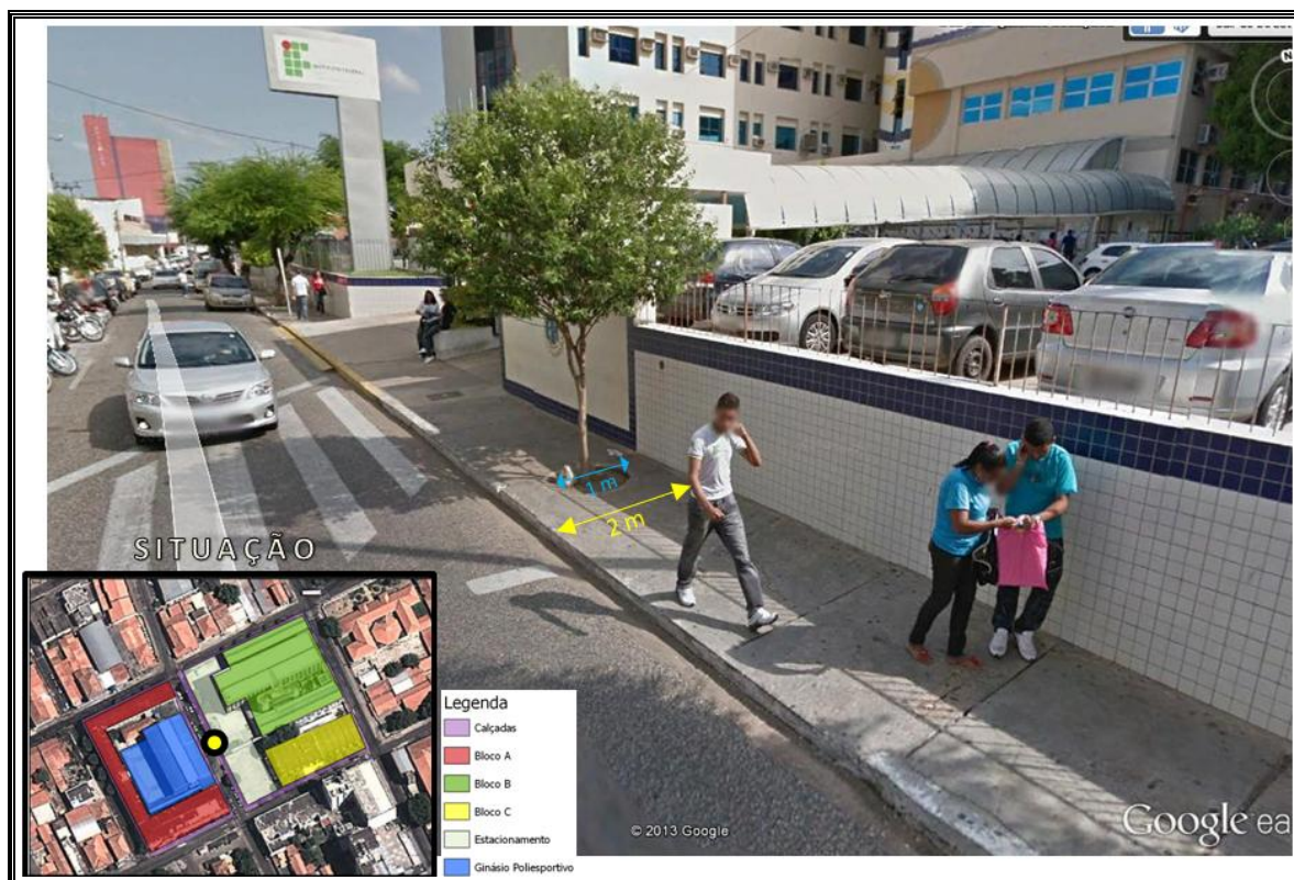
Figura 28 - Passeios públicos dos prédios B e C do Campus Teresina Central do IFPI
