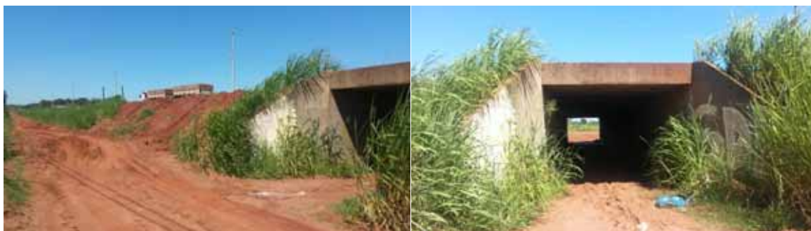
Fotografia 7 – Túnel que atravessa a Rodovia Raposo Tavares / 28-04-2014
