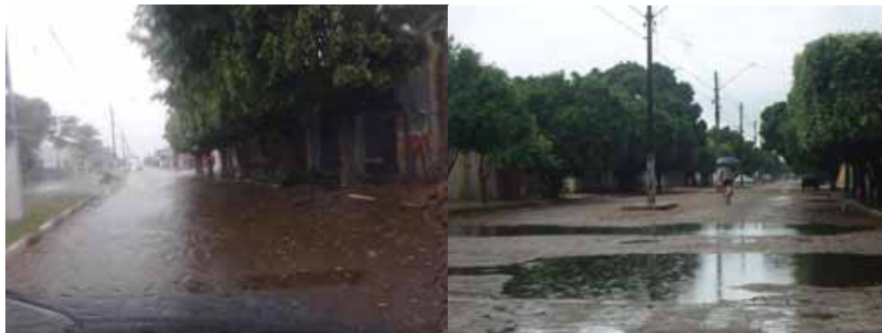
Fotografia 3 – Acúmulo de água pela ausência de galerias pluviais e blocos abaulados / 28-02-2013
