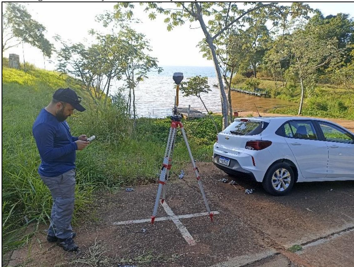
Figura 61: Instalação da base no tripé no ponto de coordenadas conhecidas
