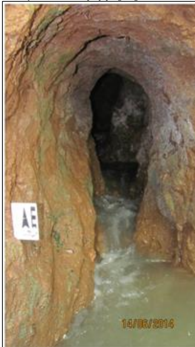
Figura 8: Feição erosiva do tipo piping, registrada em Candói-PR.
