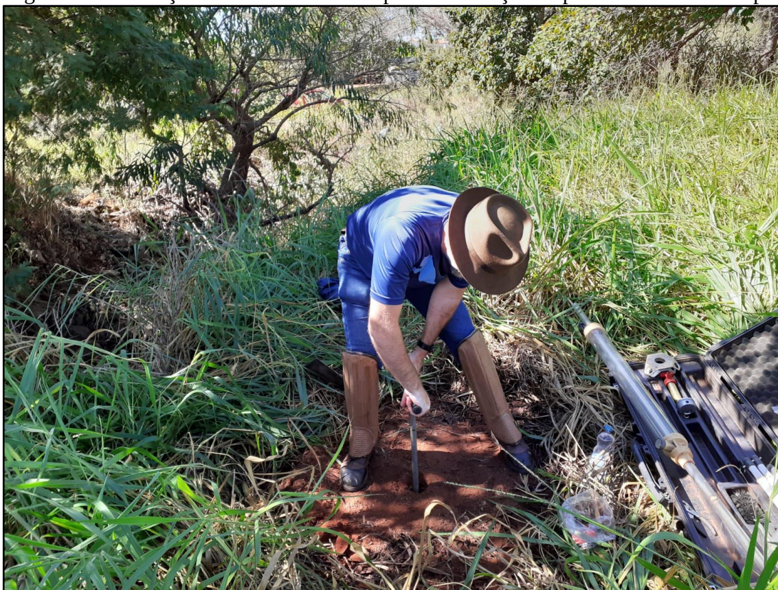
Figura 52: Perfuração do solo com o trado para a instalação do permeâmetro de Guelph.
