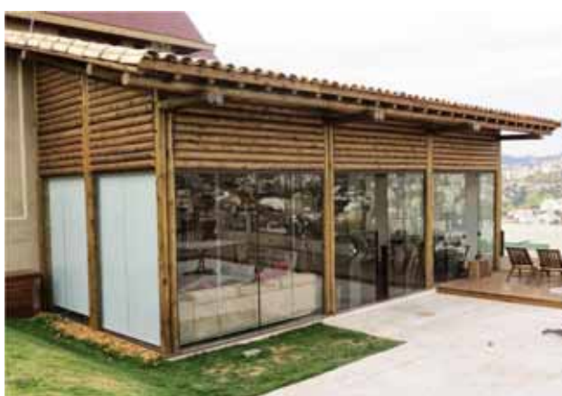
Figura 8: Construção feita com Amaru Perfilado.
