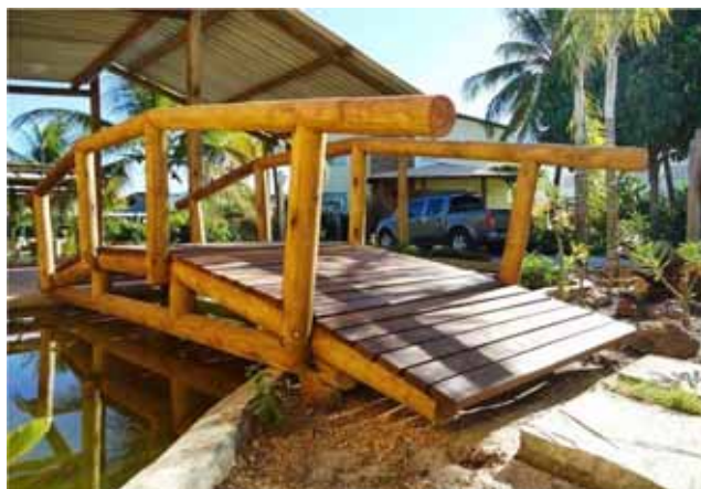
Figura 9: Estrutura de passarela de pedestres feita com Amaru Perfilado.
