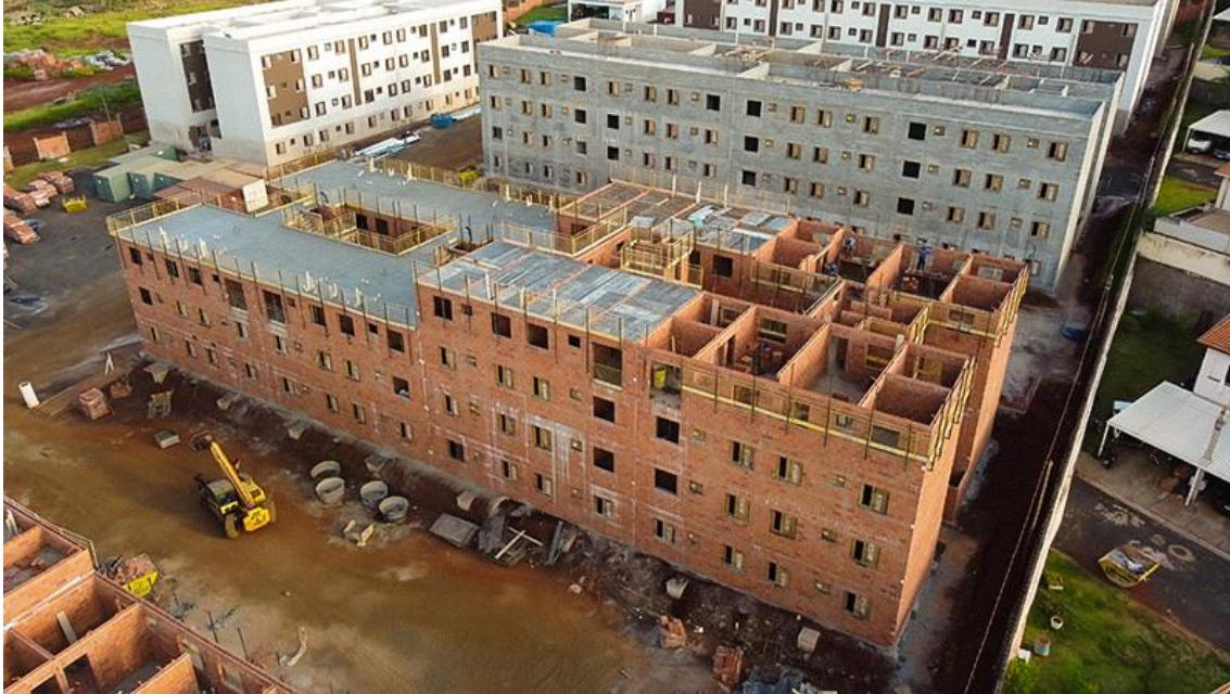
Figura 23 – Torres de Blocos de Concreto e de Blocos Cerâmicos
