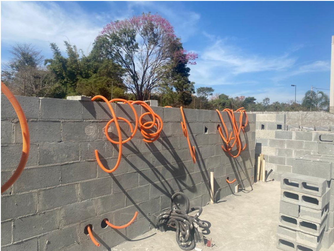
Figura 19 – Eletrodutos posicionados em alvenaria estrutural
