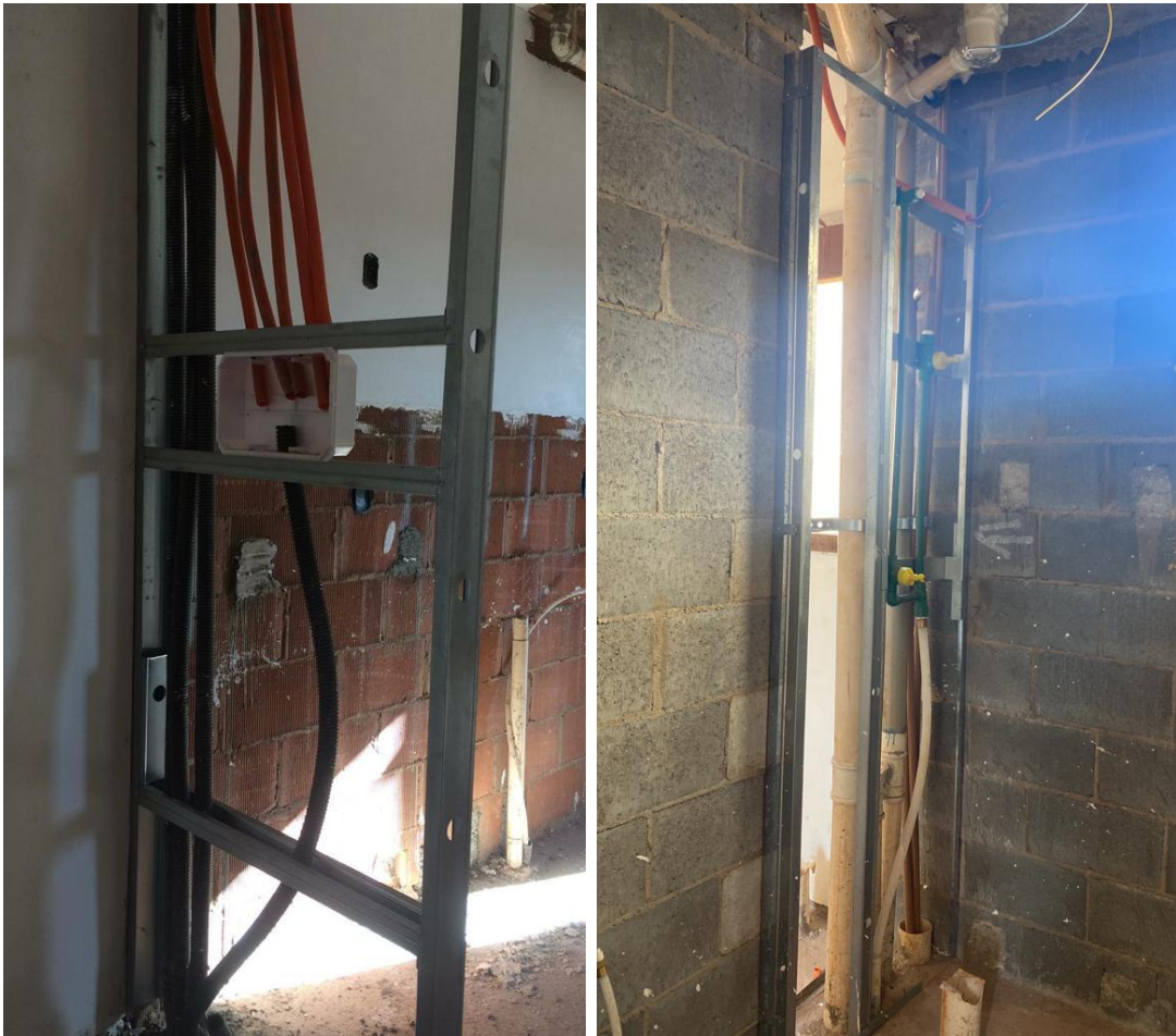
Figura 18 – Guias e montantes para shafts de elétrica e hidráulica
