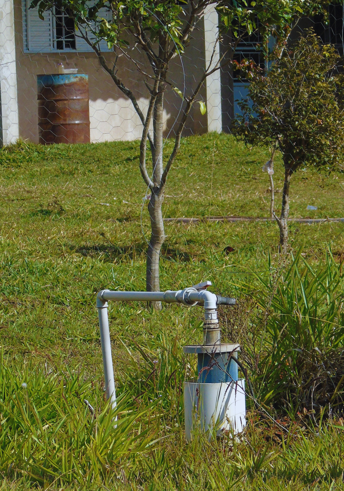
Figura 71- Poço para captação de água em Chacreamento. Alf. Marcondes. Tirada pelo autor, 2025.
