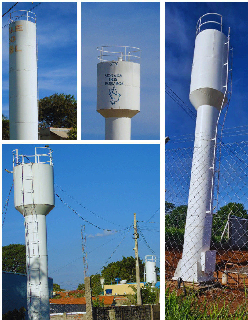
Figuras 83, 84, 85 e 86 - Caixas d'água Chacreamento 02. Tiradas pelo autor, 2025 e 2026.
