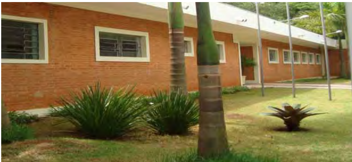
Foto: Prédio-sede da Patrulha Juvenil de Garça
