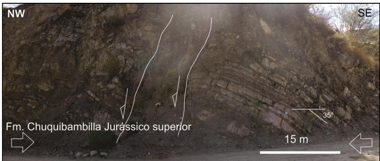
Figura 5.4. Calcários em Camadas da Formação Chuquibambilla deformadas, localizadas sobre o traço da falha Mollebamba, na localidade de Mollebamba. A atitude dos planos da falha são N60E/45NW e N70E/50NW, com estrias 30° normal sinistral.
