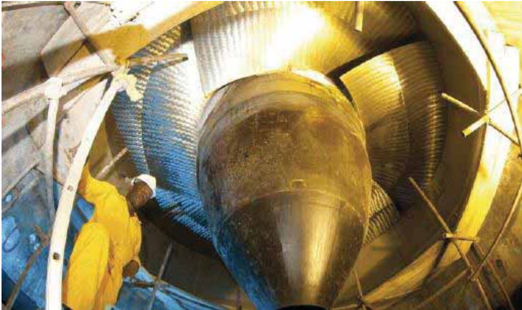
Figura 12 – Vista inferior de uma roda de turbina Kaplan em fase de montagem.
