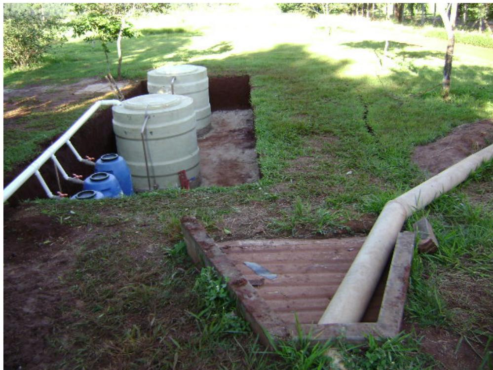
Figura 6: Sistema de captação de água pluvial instalado nas dependências do CEA.
