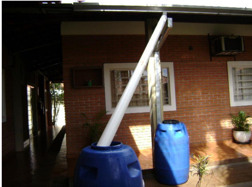
Figura 7: Coleta de água pluvial em reservatório plástico em 10/03/08.
