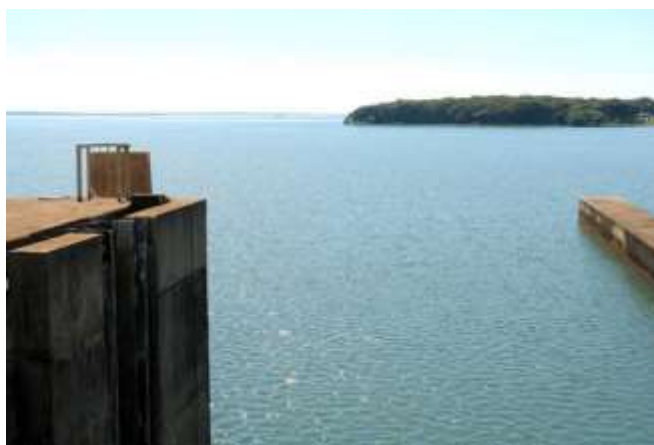
Figura 1 – Construção da eclusa de Ilha Solteira.
