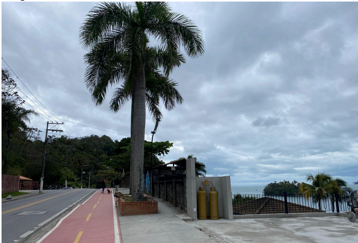
Imagens 34, 35 e 36 - Estrada do sul da Ilha, trecho da Ilha das Cabras, 2025
