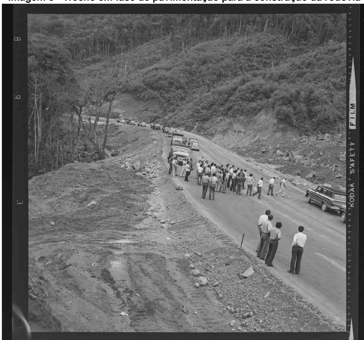
Imagem 5 - Trecho em fase de pavimentação para a construção da rodovia
