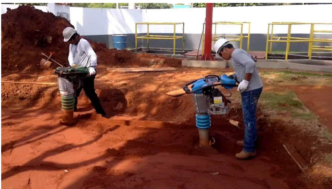
Figura 7: Obra urbana usando compactação do solo
