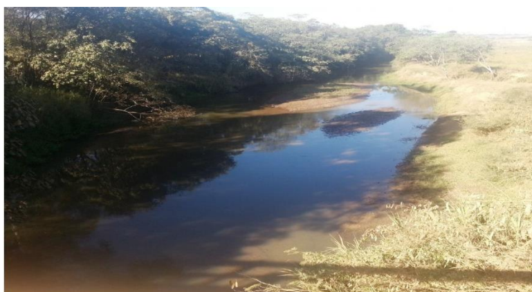
Figura 9. Vista da Ponte na Estrada do Pantano, Bairro Santa Laura, Pouso Alegre, Minas Gerais
