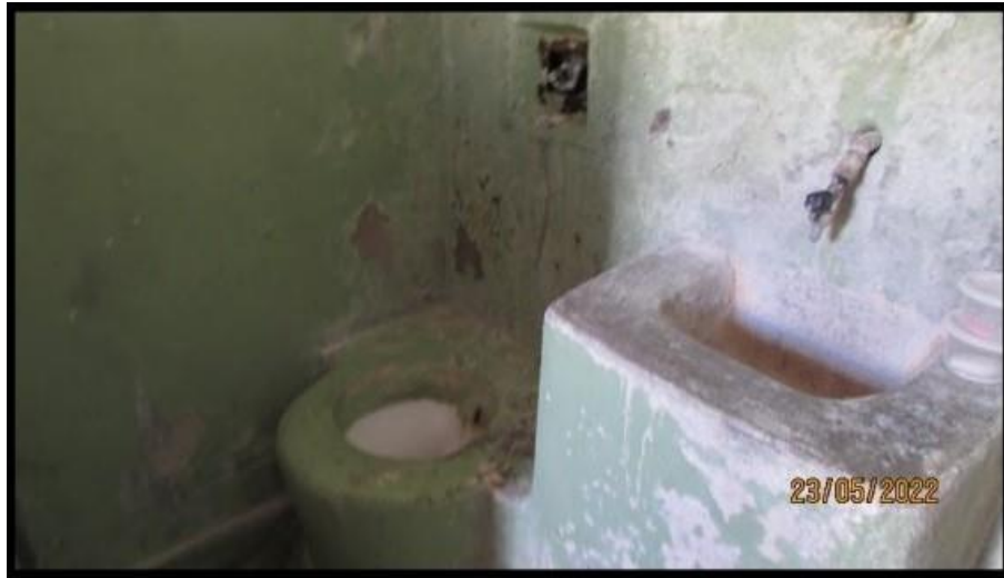
Figura 9 - Banheiro de Cella em Unidade Prisional de Minas Gerais
