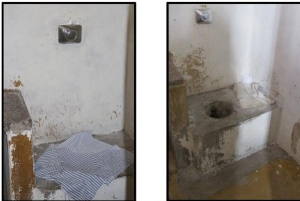
Figura 11 - Banheiro de Alojamento em Unidade Socioeducativa de Minas Gerais
