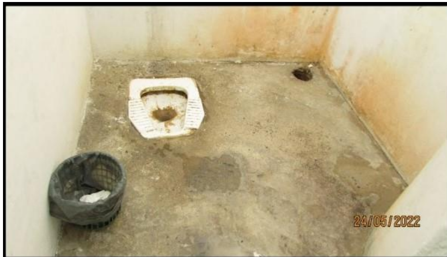
Figura 10 - Banheiro de Alojamento em Unidade Socioeducativa de Minas Gerais
