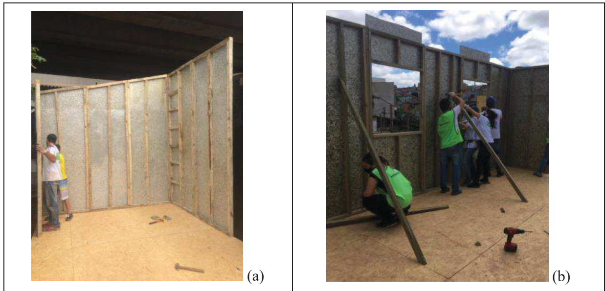
Figura 12 - (a) Montagem das paredes, (b) Painéis escorados
