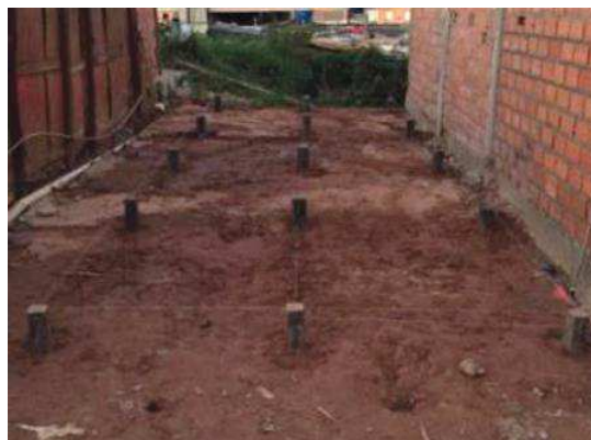
Figura 4 - Etapa de fundação concluída.
