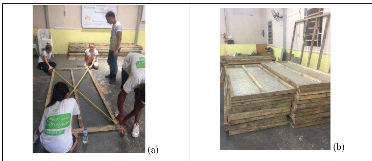
Figura 9- (a) Checagem do esquadro, (b) Etapa de confecção dos painéis concluída
