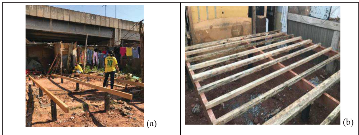
Figura 10 - (a) Fixação das vigas, (b) Instalação dos barrotes.
