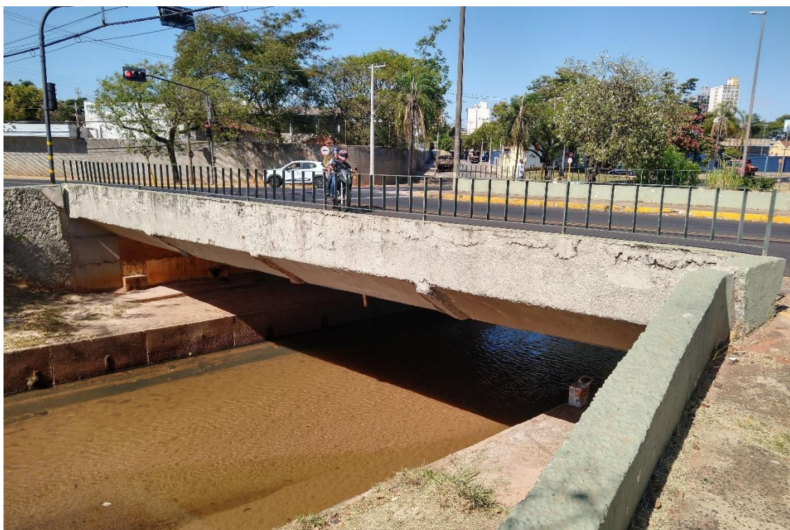
Figura 3.3: Vista geral da ponte, lado Bairro (SMO, 2022).
