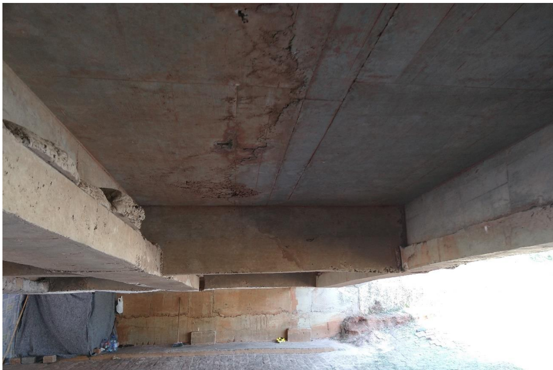
Figura 3.5: Vista das longarinas e transversinas da ponte (SMO, 2022).
