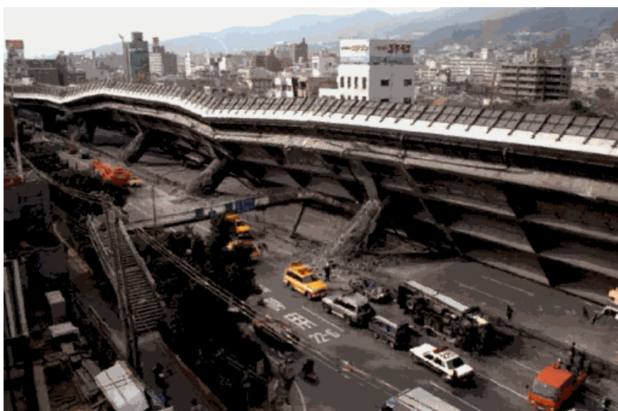
Figura 1.1 – Terremoto ocorrido em Kobe, Japão ( http://www.unb.br/ig/sis/catastr.htm )
