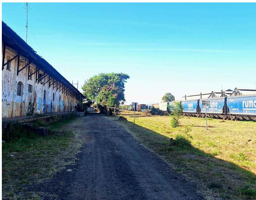
Foto 14: Fundo dos galpões e o pátio de manobras em 03/09/2025.
