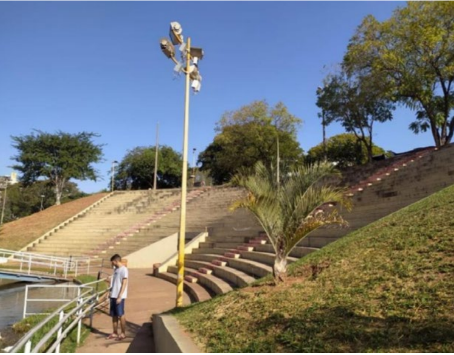
Figura 31: Arquibancadas. Na base, uma rampa de acesso ao palco, no topo, o grande platô.
