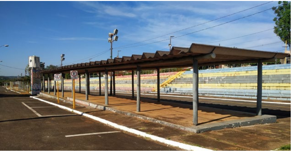
Figura 28: Cobertura e arquibancadas (Nov/2022)
