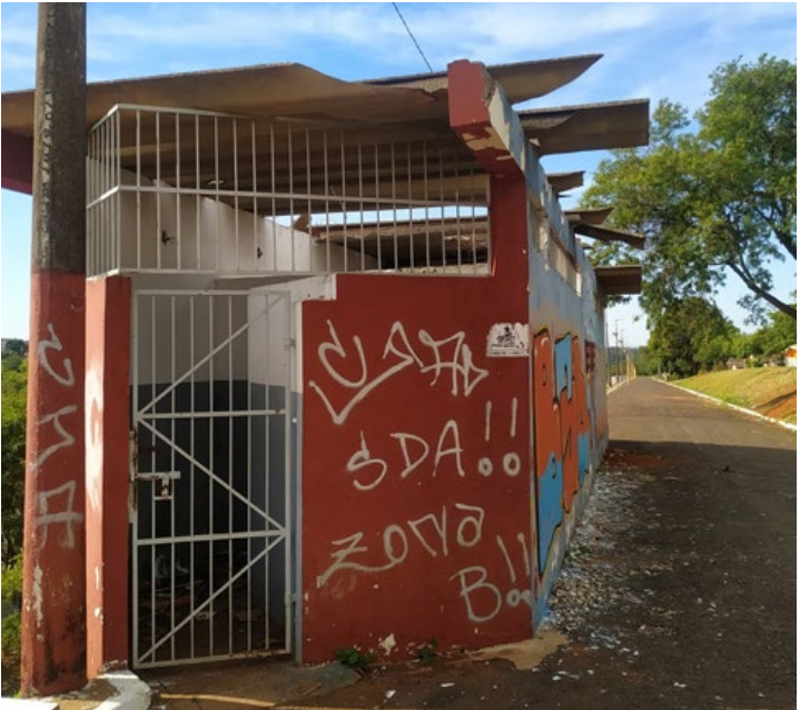
Figura 27: Banheiro do Sambódromo (Nov/2022)
