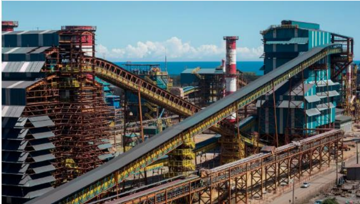
Figura 9: Vista Geral das Usinas 3 e 4, em Ubu, Espírito Santo
