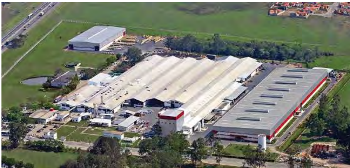
Foto 17: Nexans, localizada próximo à rodovia BR 116 no município de Lorena – SP.
