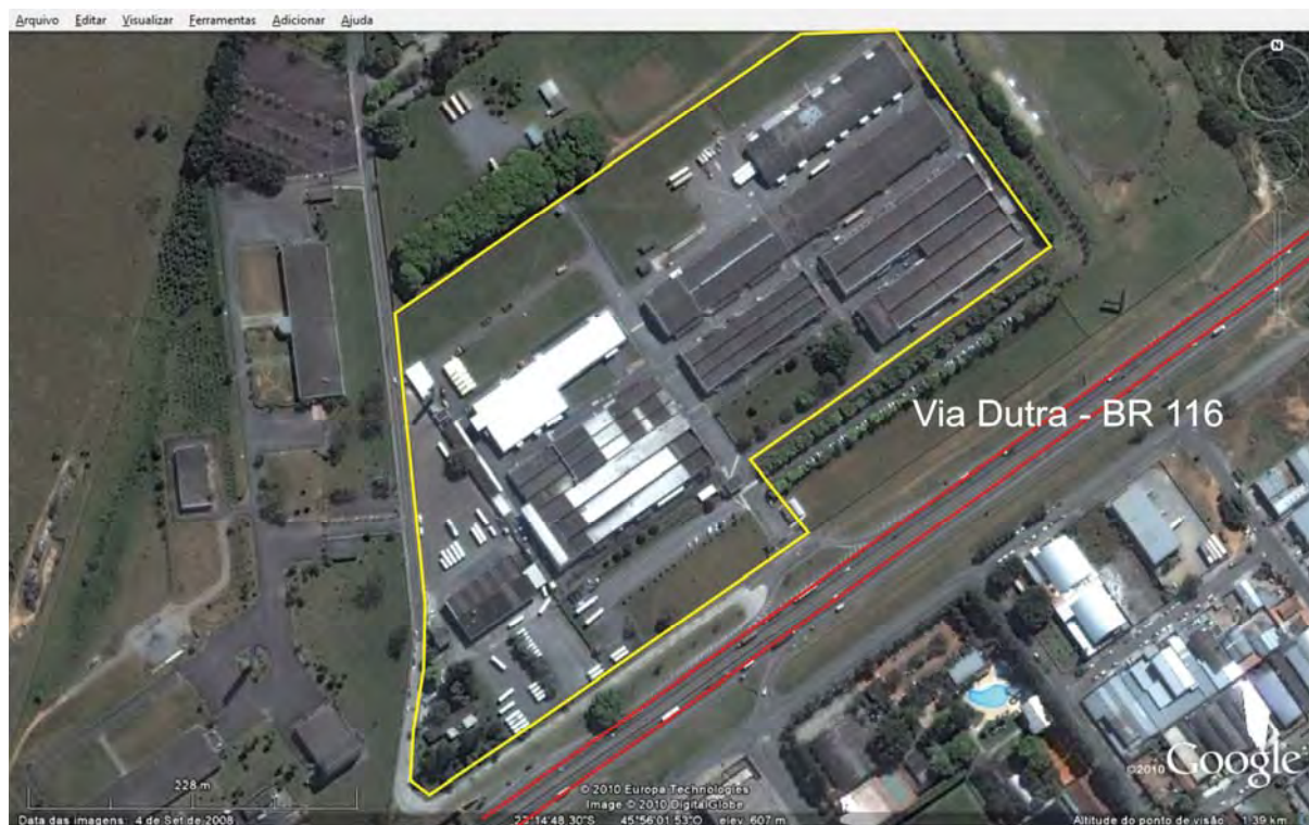
Figura 21: Panasonic do Brasil, localizada ao lado da rodovia BR 116 no município de São José dos Campos – SP.
