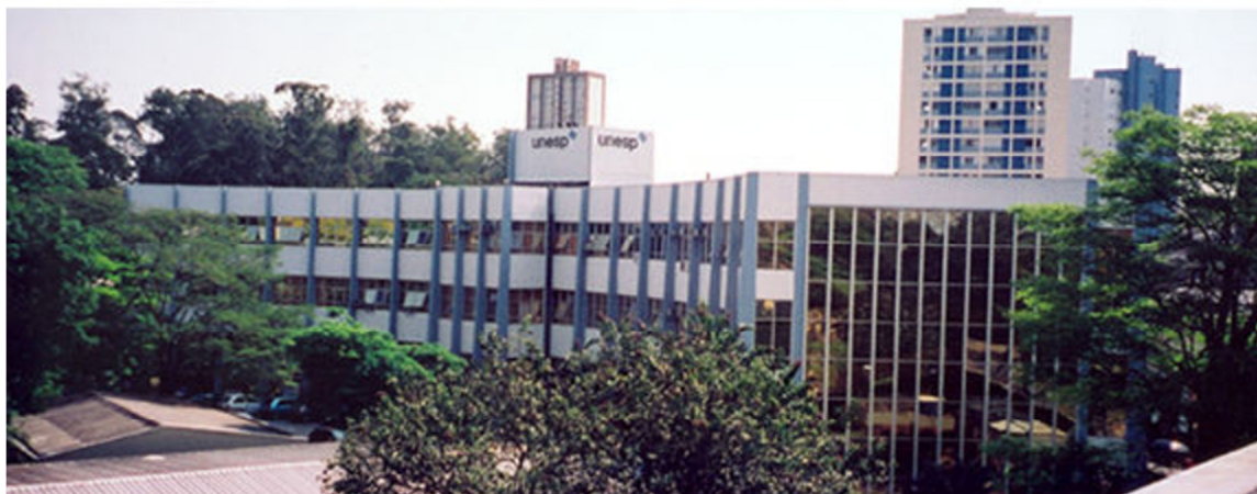
Figura1. Edifício das Clínicas – Campus São José dos Campos
