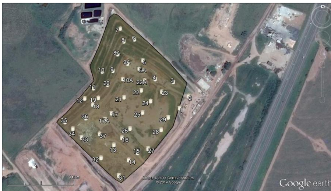
Figura 8: Georreferenciamento e identificação dos drenos do aterro de Rio Claro – SP.
