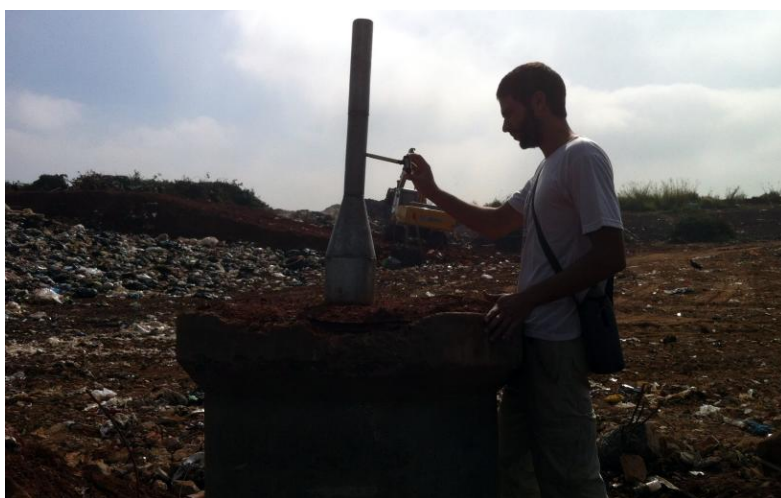
Figura 11: Medição de velocidade de saída do biogás em dreno do aterro sanitário de Rio Claro (SP) com o auxílio do termo anemômetro digital portátil e a “chaminé”.
