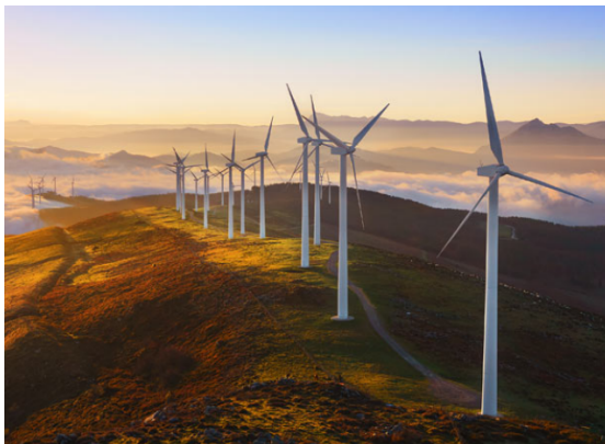
Figura 2.2: Parques eólicos instalados em terra
